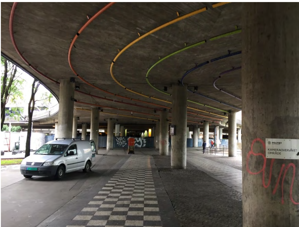
Illustrasjon 5. Olafsiagang-området under broen. Legg merke til kameraovervåkingskiltet som politiet har satt opp. Foto: Bengt Andersen
