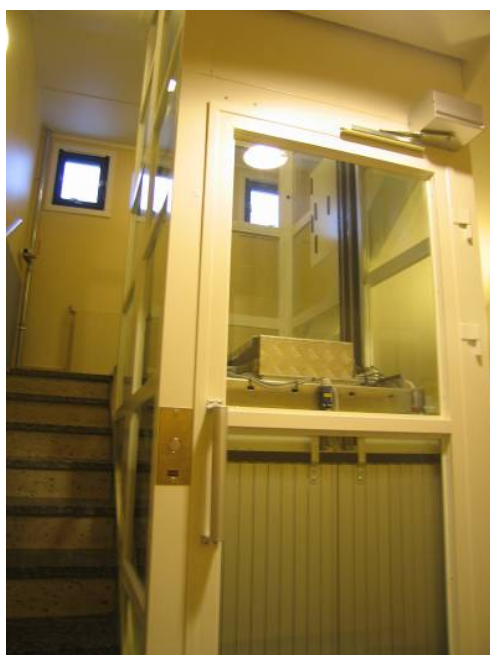
Figur 3.17 Heis med innvendig lamelldørsom åpnes til siden
