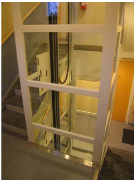
Figur 3.17 Heis med innvendig lamelldørsom åpnes til siden
