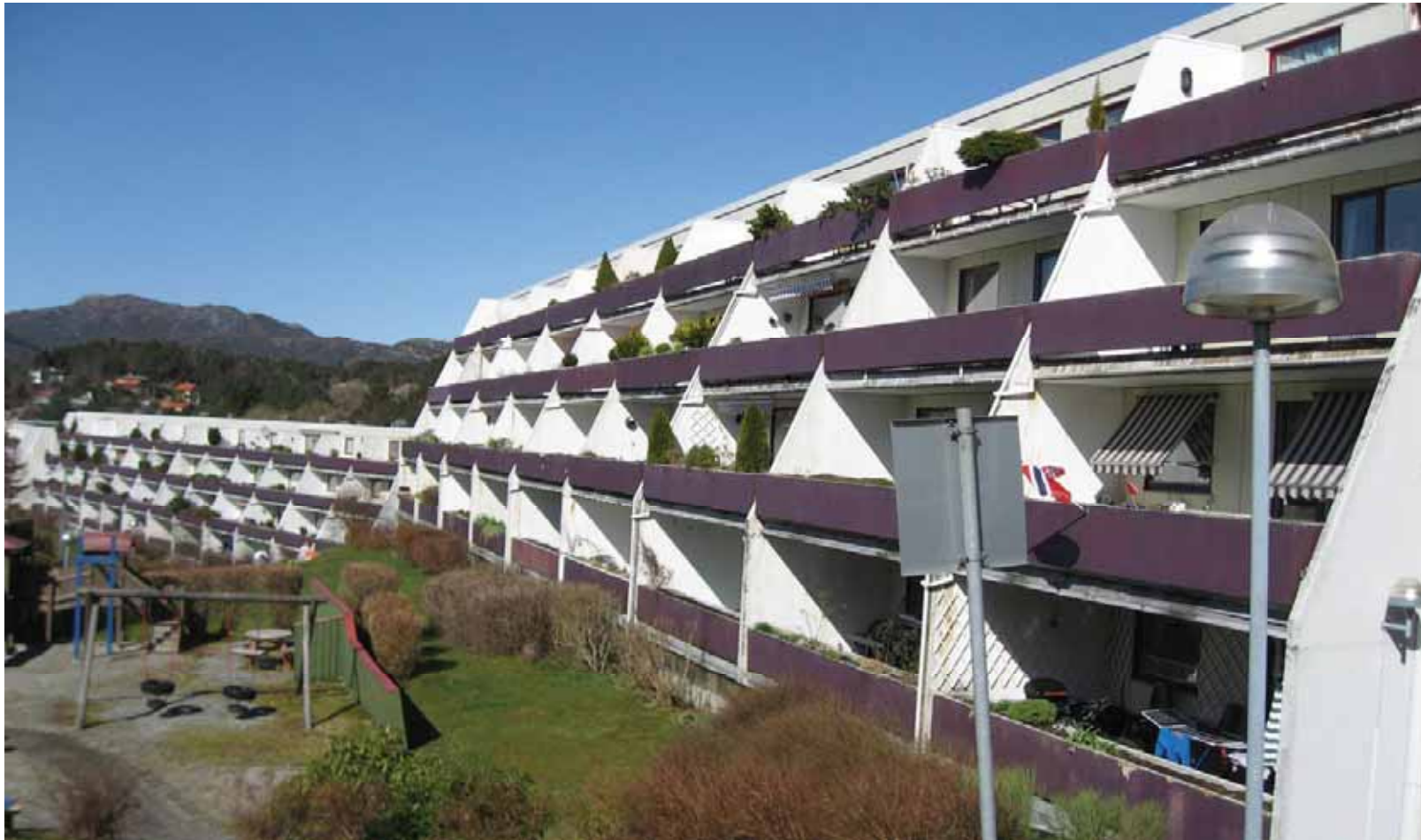
Solrike balkonger som skal bli innglasset for helårsbruk
