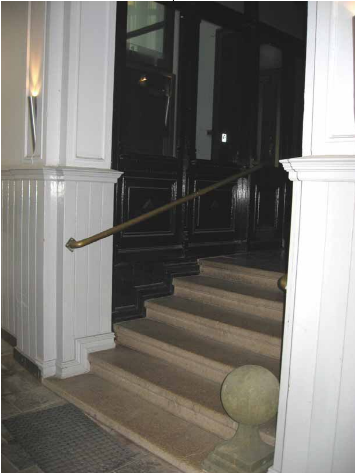
Trapp fra portrom til inngangen med heis
