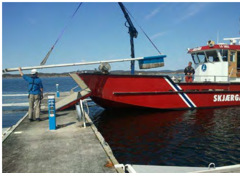
Montering av utriggere. Foto: Terje Mindrebø, Skjærgårdstjenesten i Kragerø
