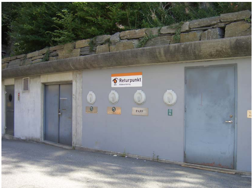
Figur 7. Som ett av svært få prosjekter har Georgernes verft et gjennomtenkt anlegg for kildesortering. Innkast for de ulike fraksjonene er plassert diskret inntil beplantning, men lett tilgjengelig for beboerne. Returpunkt for flere fraksjoner ligger ved utkjøringen fra garasjen.
