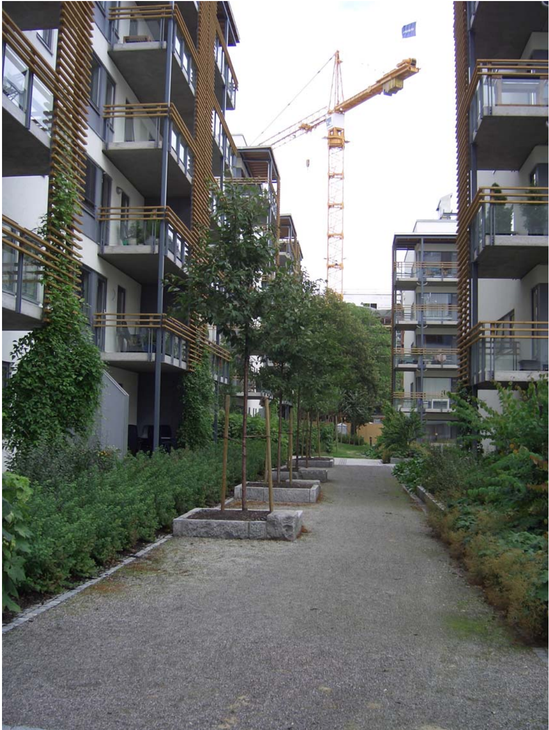
Figur 10. Permeable (gjennomtrengelige) flater fordroyer overvann ved store nedbørmengder. Her i Pilestredet park letter fordroyningen av overvannet kapasitetsproblemene i Oslo sentrum.
