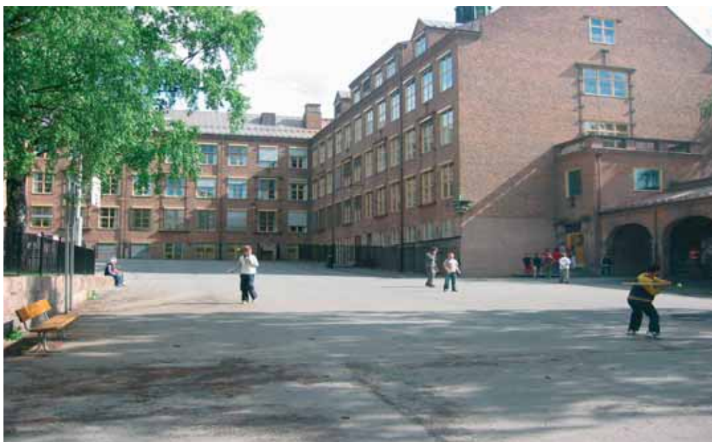
Figur 8.4 Sagene skole er av høy håndverksmessig kvalitet, og har tålt tidens tann. Skolegården derimot trenger oppgradering.
