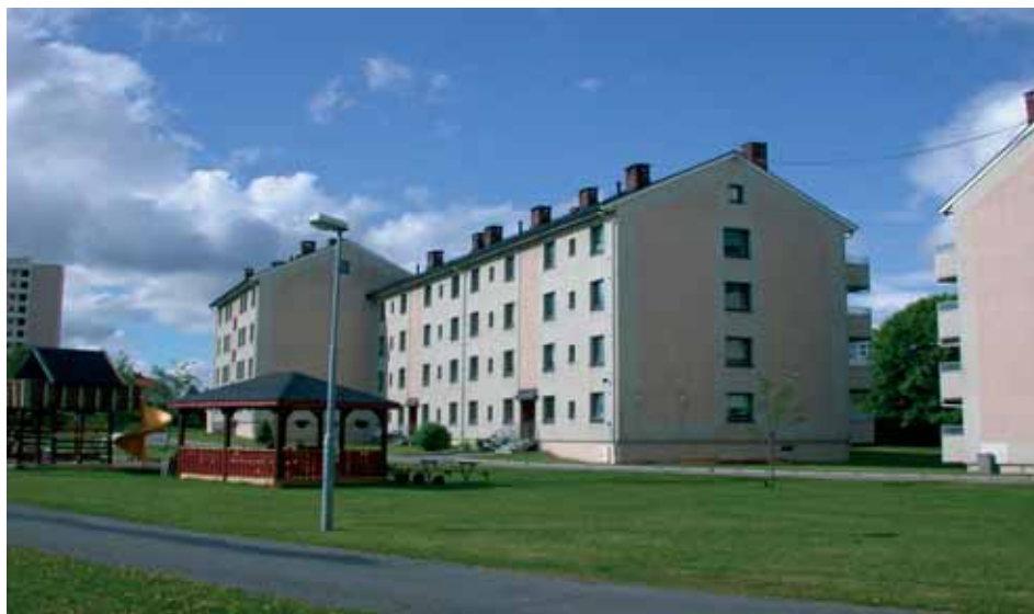
Figur 7.3 Bebyggelsen har et enkelt formspråk med klare former. Mellom bygninger er det store grøntområder. Arealene mellom blokkene mot Ringveien er lite opparbeidet. Uteplassen er lagt her fordi balkongene er for støyutsatte.
