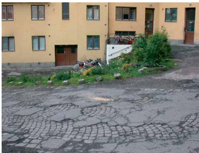
Figur 8.7 Dette store åpne gårdsrommet har preg av forfall og manglende vedlikehold. Det innbyr i liten grad til opphold til tross for gode lys og solforhold og mange beboere i bygningen rundt.
