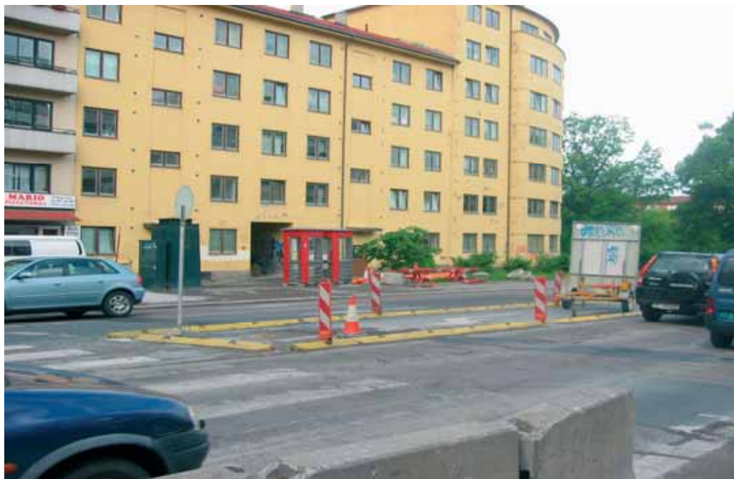
Figur 8.1 Området sett fra Ring 2. Karakteristisk funksjonalistisk bebyggelse med store arkitektoniske kvaliteter, men fasadene er dårlig vedlikeholdt med flassende maling og skader i pussen. Den tidligere kommunale bygården er nylig overtatt av beboerne, og organisert som borettslag. I bakgrunnen ses grøntområdene langs Akerselva.
