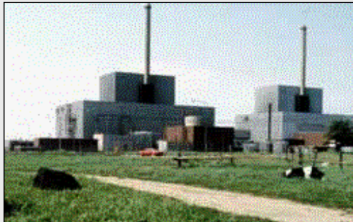
Kjernerkraftverket Barsebäck 1 og 2 i Sverige. Mange av atomkraftverkene i både Øst- og Vest-Europa er relativt gamle.
