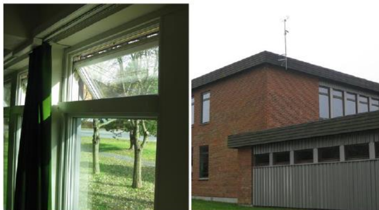
Figur 3.3, Automatisk styrt vindu for luftinntak av bygget og værstasjonen på taket, [17]
