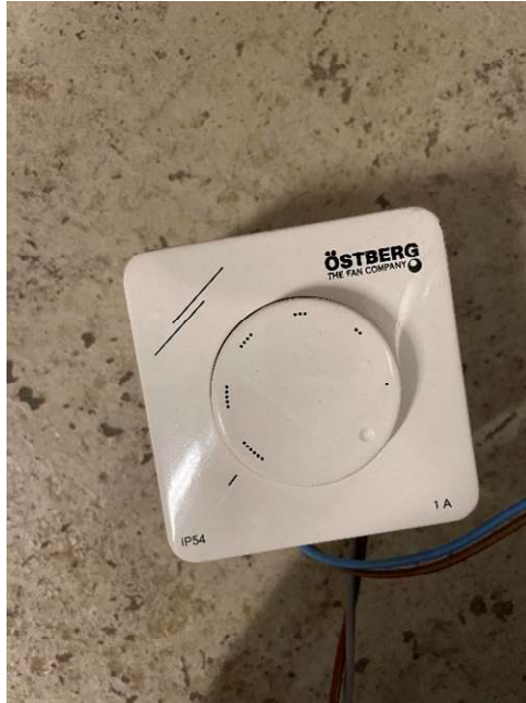
Figur 3.2.1-1 (hastighetsregulator koblet opp mot CK vifte)
