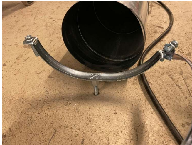
Figur 3.3.1 (oppheng ble montert ned i bakken)
