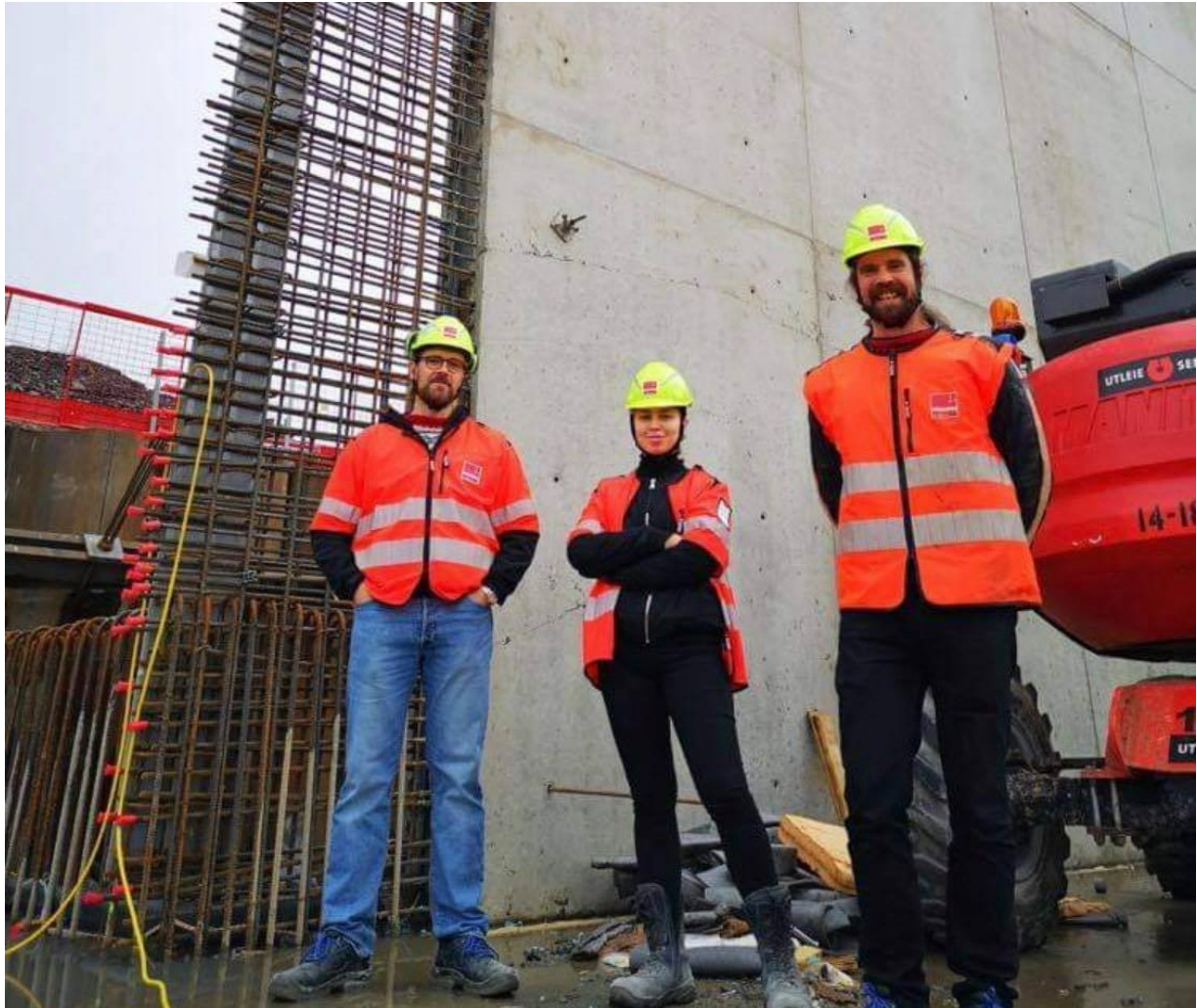
Bilde 1: Oppgavens forfattere inspiserer støping av høyvegger på Oksenøya i Bærum høsten 2020. Fra venstre: Andreas J. Hansen, Sila Bozkurt og Nils Ove Børve.
