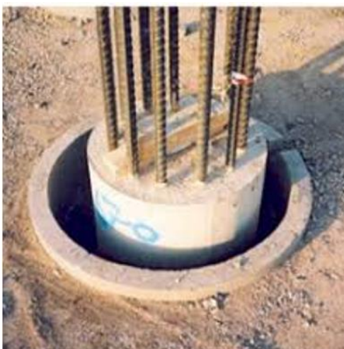
Figur 4.8 a) Illustrere pel fundamenter av «post holes» b) Viser detaljtegning av pel fundament kombinert med jordarmerte løsning (Pétursson, 2006)
