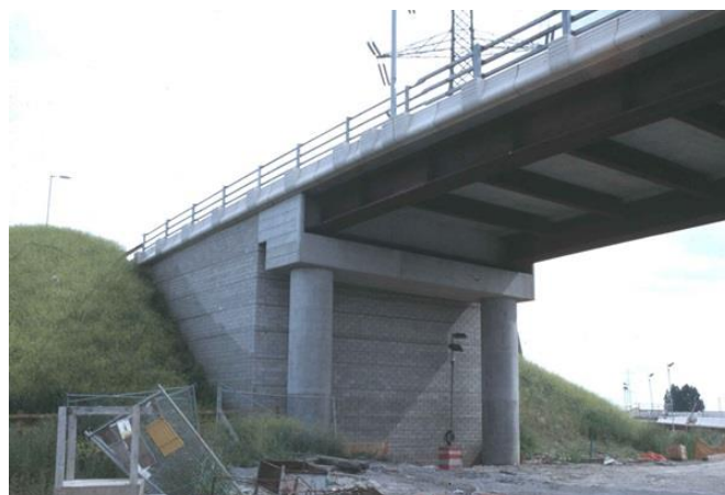
Figur 2.1: Viser landkar som bærekonstruksjon til brooverbygging
