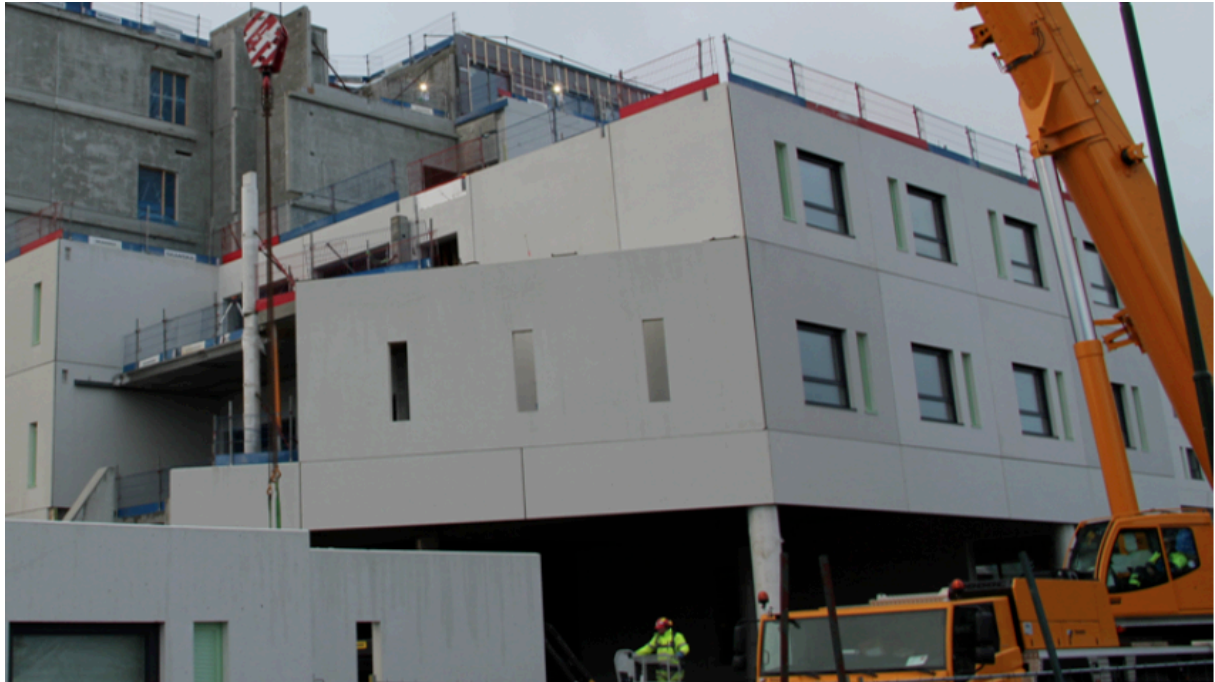
Figur 5 Bygging av eldreheim i Stavanger 2016 [19]
