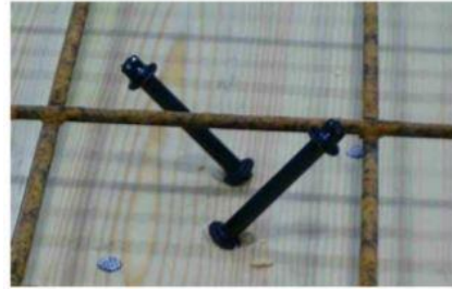
Figur 2.4: Spesialskruer til skjæroverføring, Hentet fra https://www.diva-portal.org/smash/get/diva2:991048/FULLTEXT01.pdf
