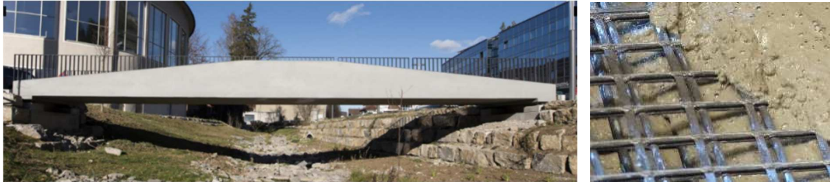
Figur 3.2-11: Albstadt-Ebingen bridge, en av flere bruer utelukkende armert med FRP. Kilde: techtextil-blog.com.
