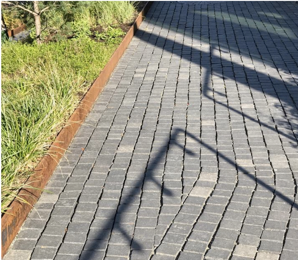
Figur 4 Belegningsstein med åpne fuger for infiltrasjon i Bjørvika, Oslo
