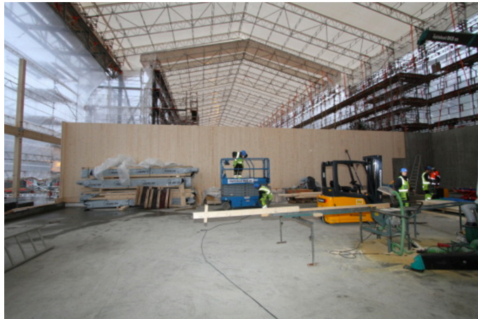
Figur 14. Ulsmåg skole i Bergen bygges i massivtre under plasttelt, 2014 [24].
