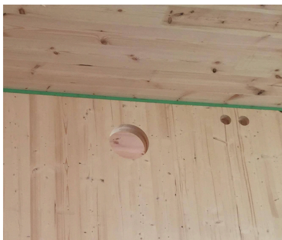
Figur 21. Massivtreelement med hull til føringer (Foto: Privat, Bjørkelangen skole)
