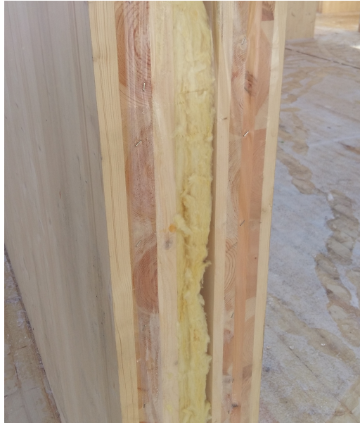
Figur 51. Dobbelveggkonstruksjon av massivtre (Foto: Privat, Bjørkelangen skole).
