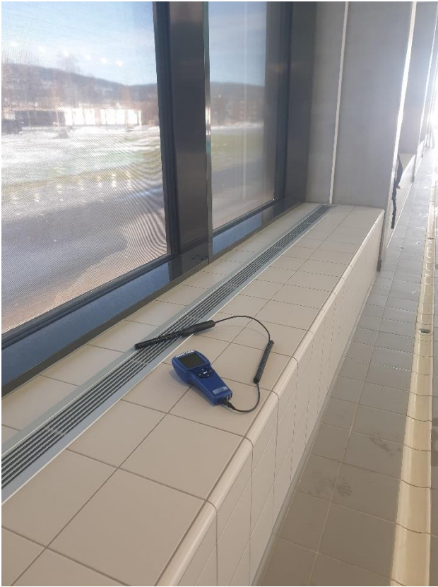
Figure 8 Tilluft i Rud Svømmehallen
