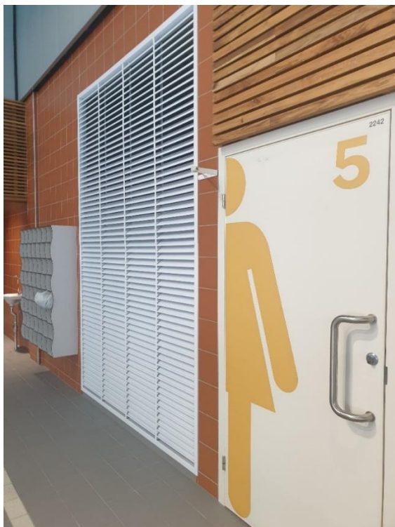
Figure 7 Avtrekk i Rud Svømmehallen
