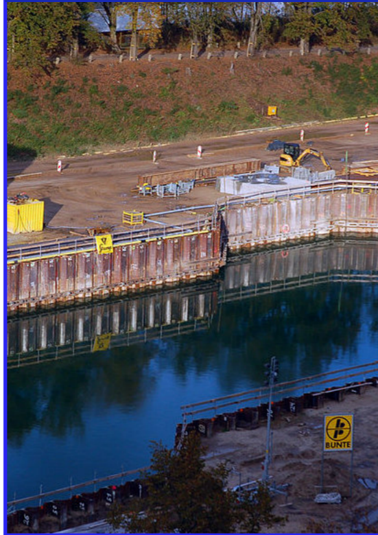
Figure 12: Sheet piling, by Ralf Roletschek, 2009, https://commons.wikimedia.org/wiki/File:2009-10-19-schiffshebewerk-niederfinow-neubau-by-RalfR-27.jpg . Creative commons
