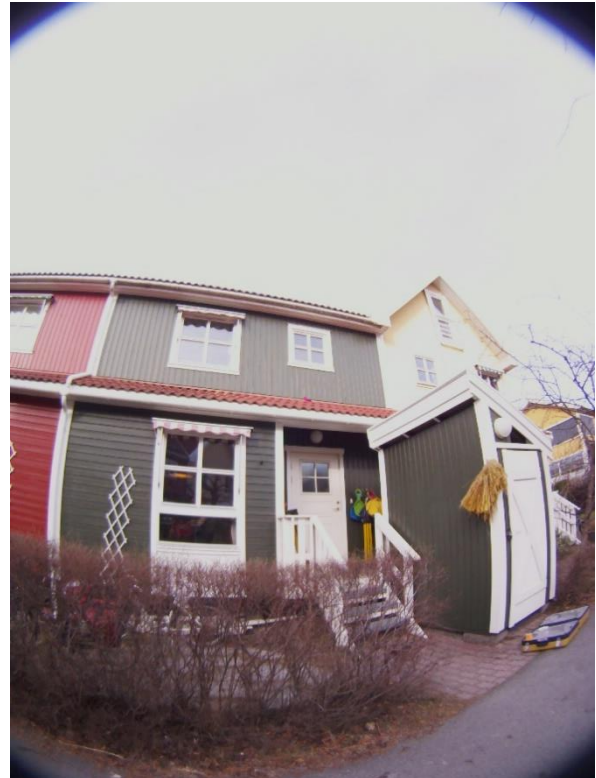
Figur 28 viser rekkehuset i virkeligheten
