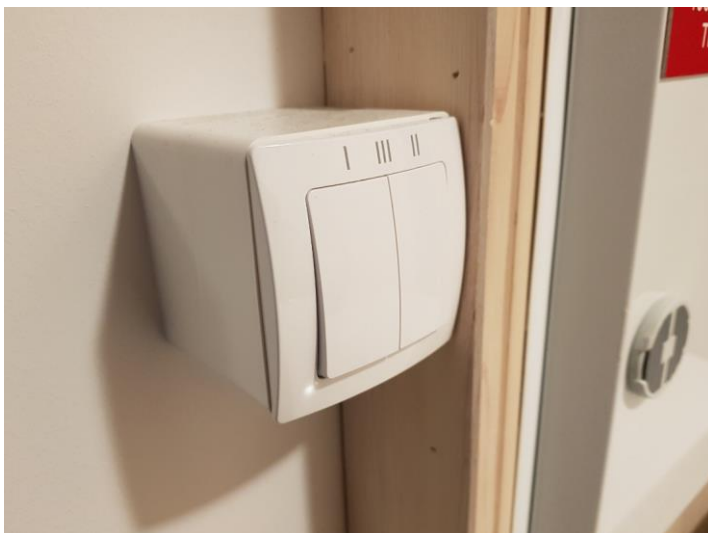
Figur 2.5: Bilde viser Lunos 5-UNI-FT bryter i bod stilt inn på høyeste luftmengde av beboer
