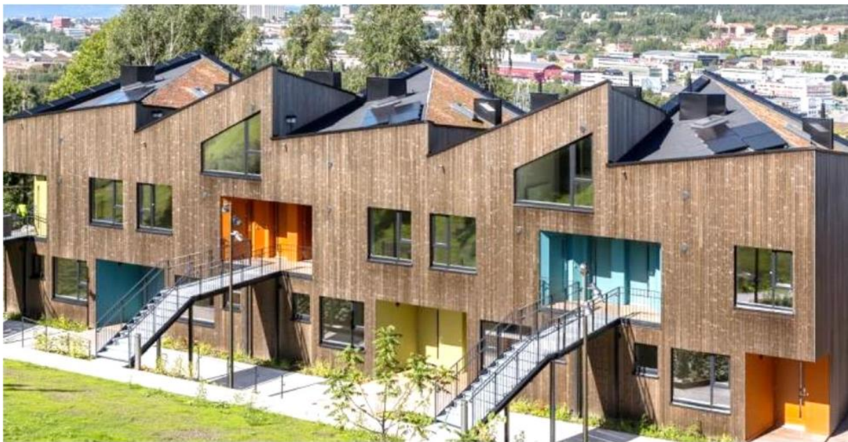
Figur 2.1: Bygning A i Ulsholtveien 31
