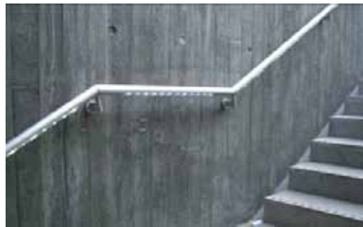
Lyslist i rekkverket på Femøren T-banestasjon utenfor Kastrup. Photo: SINTEFF byggforsk
