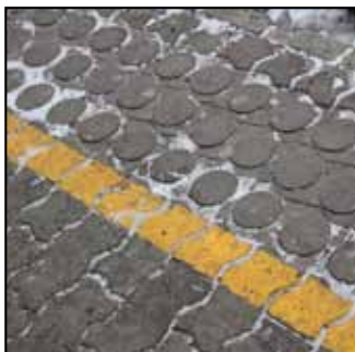
På bildet: Ledelinjer og førelinjer i gategrunn på togperrong, Oslo S.
