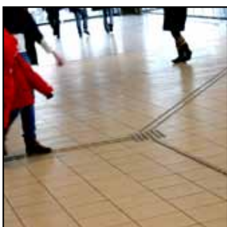
På bildet: Taktile merker på gulv i hovedbygget til Oslo S.
