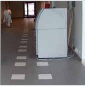
På bildet: Eksempel på hvordan hindringer kan stoppe både ledelinjer i gulv og vegg.
