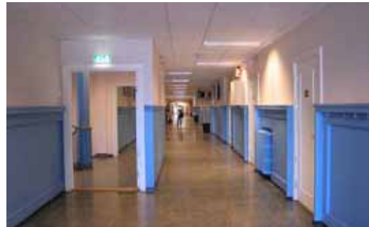
Korridor på Ullern videregående. Photo: SINTEFF byggforsk
