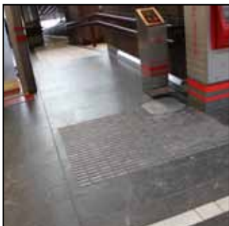
På bildet: Advarselindikatorer foran nedgang til perrong på Oslo S.
