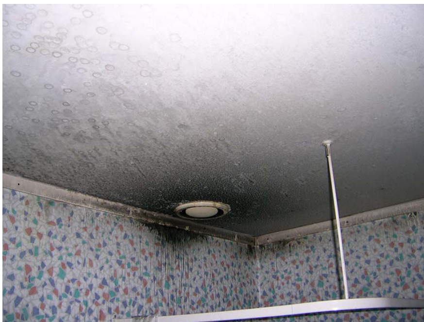
Figur 4.2: Avtrekksventil på soverom - Røykspredning som vist på bildet ble funnet på de fleste pasientrommene. Foto: DSB
