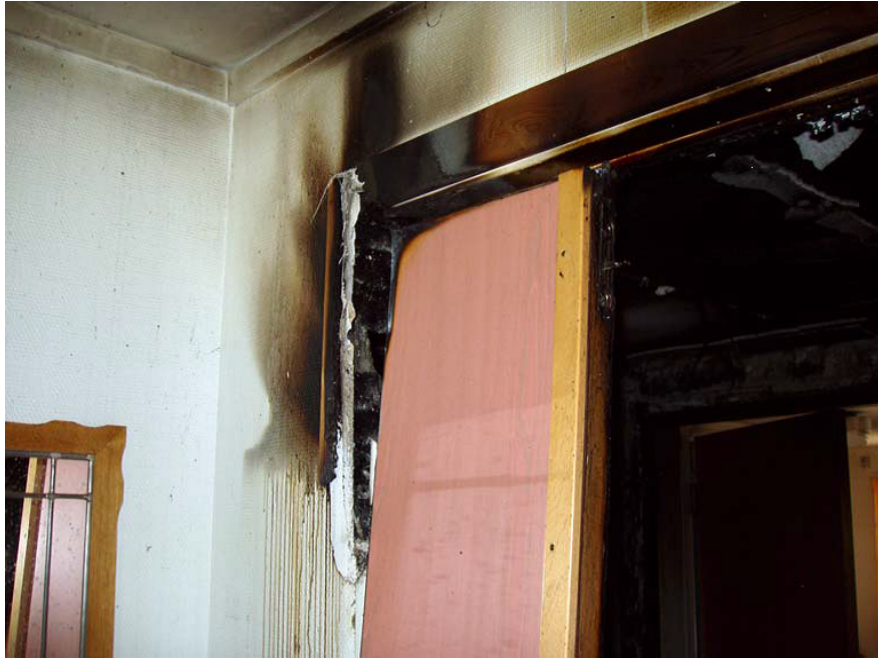
Figur 4.3: Gjennombrent dørkarm - Foto: DSB
