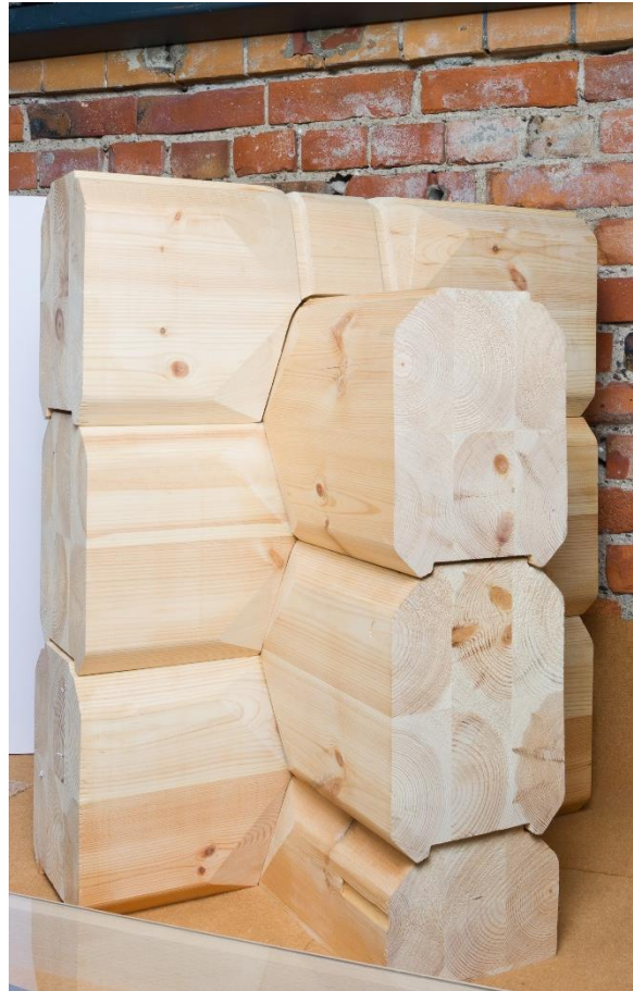
Foto 4 CNC-frest tømmervegg i lafteteknikk Norsk Form / Istvan Virag ©
