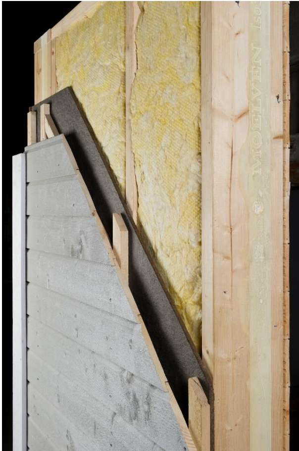
Foto 3 Tverrsnitt av vanlig Norsk husvegg Norsk Form / Istvan Virag ©
