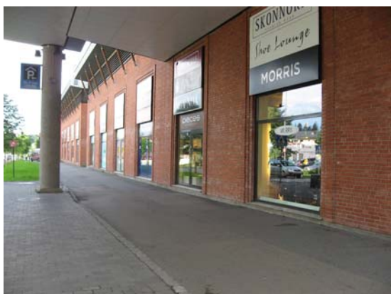
Figur 4.9 Første etappe av storsenteret har få innganger fra gaten, og gaten er dermed lite attraktiv for fotgjengere. Mulige innganger er lukket og butikkvinduer er brukt til reklameformål.
