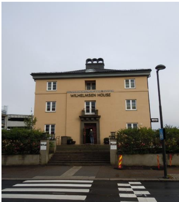
Foto 8.4: Wilhelmsen House, Tønsberg: Inngangsparti mot syd, med granittdetaljer i fasade og trapp. Rampene er lagt i bakkant av mur og trapp mot hovedvei og den universelle utformingen av tilkomst til hovedinngangen er utført på en meget diskre måte
