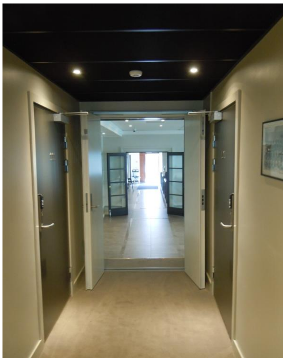
Foto 7.2: Wilhelmsen House, Tønsberg, interiørdetalj, dobbelte brannør i bakkant av tredør mellom salong og rom
