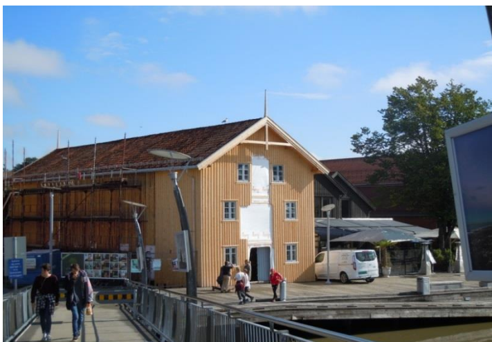
Foto 6.8: Bryggen i Tønsberg, Foyngården, nordre sjøbod, sett fra vest, under istandsettelse. Vi ser det nye bygget som bygges utenpå det originale.
