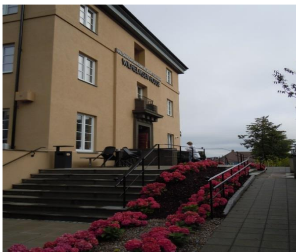
Foto 8.5: Wilhelmsen House, Tønsberg: Inngangsparti fra sydvest, med rampe lagt i bakkant av mur og trapp mot hovedvei.
