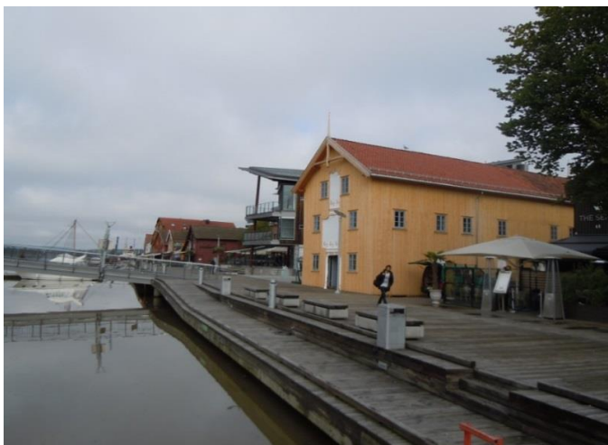
Foto 6.7: Bryggen i Tønsberg, Foyngården nordre sjøbod fra øst, under istandsettelse. Nytt bygg er bygget utenpå den opprinnelige sjøboden.
