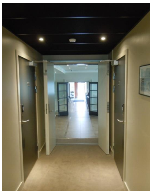
Foto 5.20: Wilhelmsen House, Tønsberg, interiørdetalj, dobbelt brannndør i bakkant av tredør mellom salong og rom
