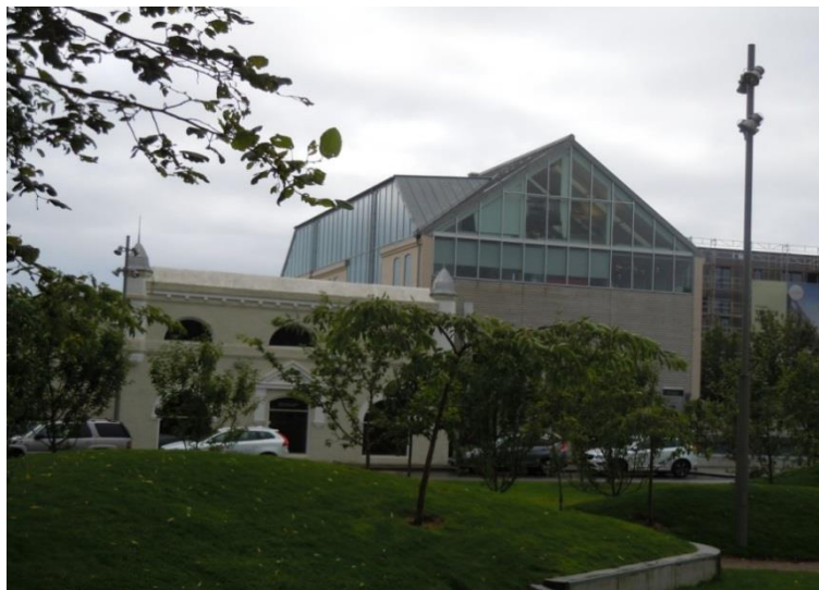
Foto 5.14: Borgen, Stavanger. Viser åpning og glassetting i gavl og mot sjøen
