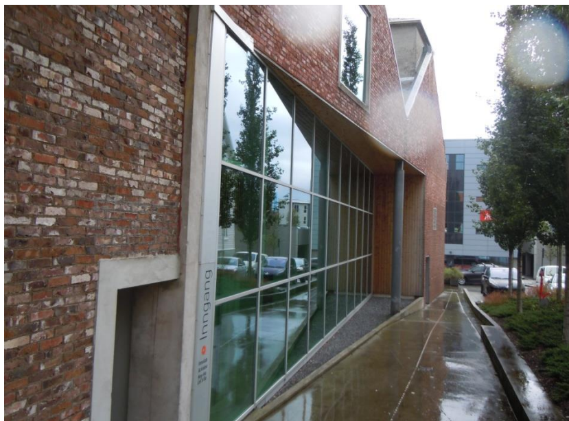
Foto 6.1: ”Oransjeriet”, Stavanger, vindusfasade, detalj. Her var det et krav fra den private utvikleren at det måtte mer lys inn i lokalet for å få det funksjonelt. I samarbeid med arkitekten, ble partene enige om denne skråskårne vinduskonstruksjonen, som var ment å gi både lys og dynamikk til byggets fasade
