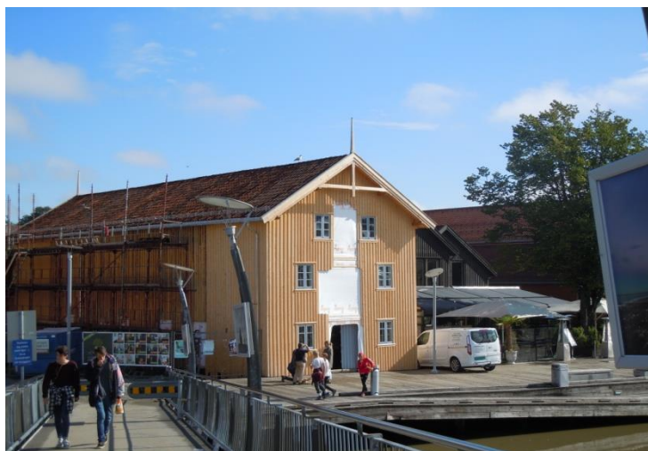
Foto 5.7: Bryggen i Tønsberg, Foyn-gården, nordre sjøbod, sett fra vest, under istandsettelse. Vi ser det nye bygget som bygges utenpå det originale
