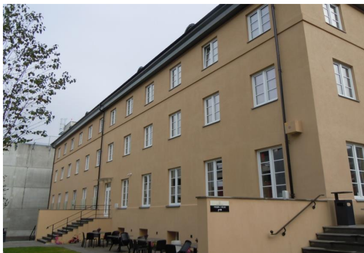
Foto 5.18: Wilhelmsen House, Tønsberg, fasade mot vest
