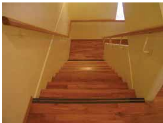
Figur v.79 Fra bad. Ingen kontrast gulv-vegg
