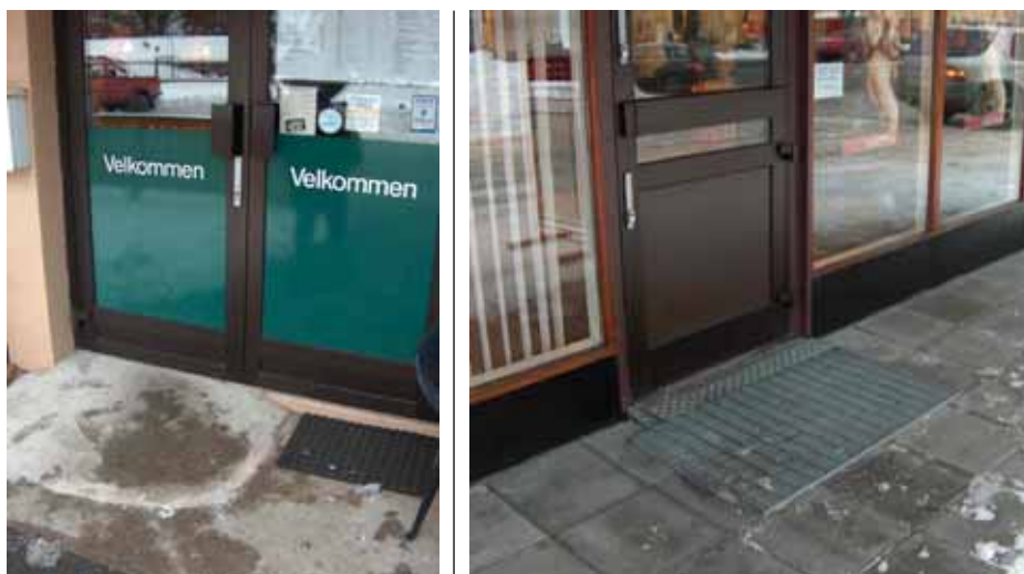
Figur v.3 Trinnfri atkomst til butikker. Slagdører (som på bildene) er ikke tilfredsstillende, men fungerer så vidt med så liten nivåforskjell som på bildet til høyre.
