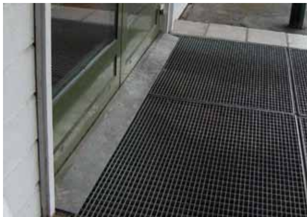
Figur v.37 Beslag for å utligne terskelhøyde på hovedinngangsdør.
