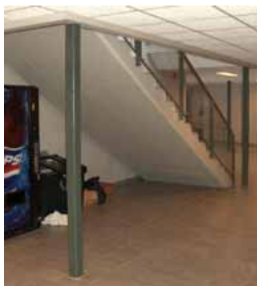
Figur v.17 Usikret underside av trapp.
