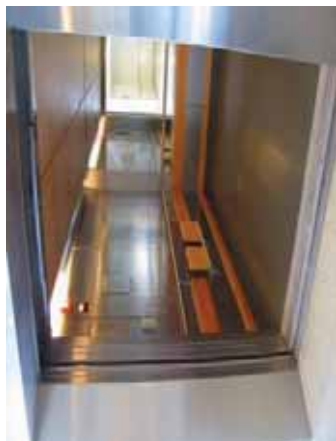
Figur v.64 Innfelt merking av forkant inntrinn
