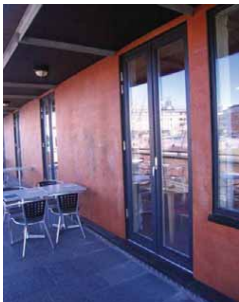
Figur v.70 Høy terskel fra restaurant til terrasse
