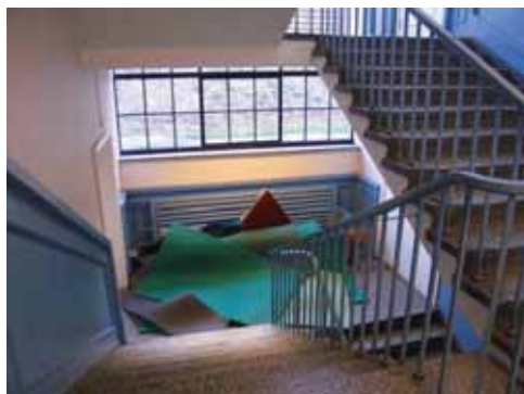
Figur v.98 Skader i himlingen
