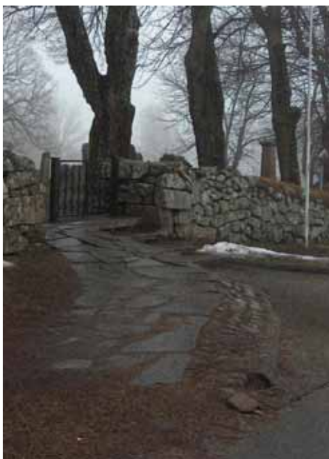
Figur v.25 Rampeatkomst til hovedport: estetisk vellykket, men vanskelig med rullestol og rullator
