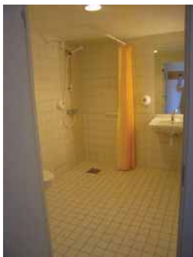
Figur v.79 Fra bad. Ingen kontrast gulv-vegg
