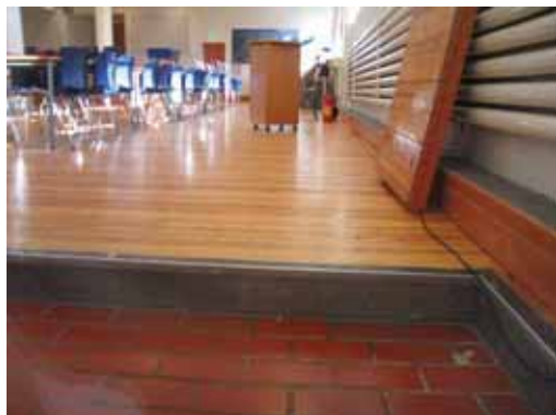
Figur v.92 Hovedtrapp med gode kontraster, men uten rekkverk og markering av trinn
