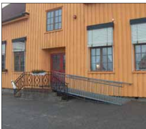
Figur v.28 Hovedinngang: Gammel steintrapp påmontert strekkmetallrampe.
