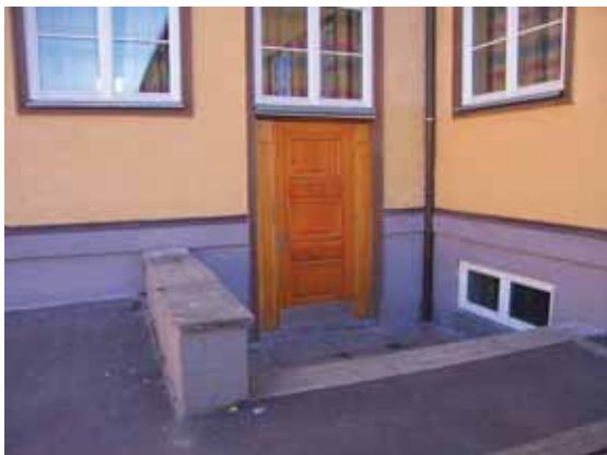
Figur v.101 Høy terskel og på utsiden er det flere trinn .
