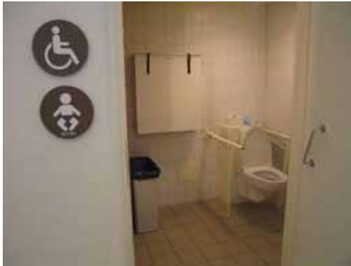
Figur v.69 Ingen kontrast dør/vegg. Barn kan ikke bruke speilet
