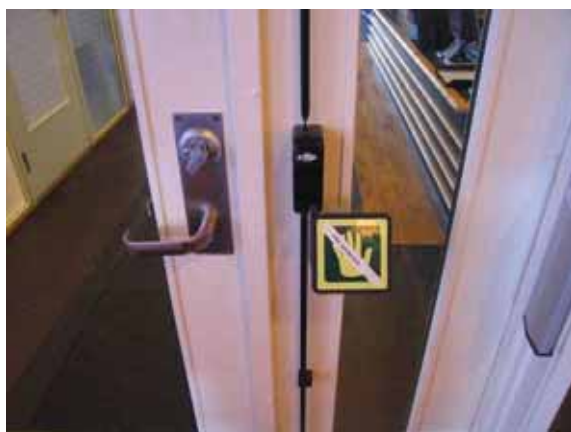
Figur v.73 Tung dør uten døråpner til spisesal
