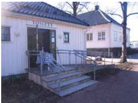
Figur v.86 Tilpasset toalettus med rampe
