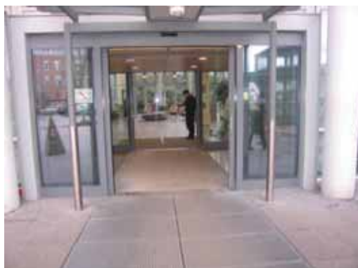
Figur v.57 Ingen merking av glassfelt
