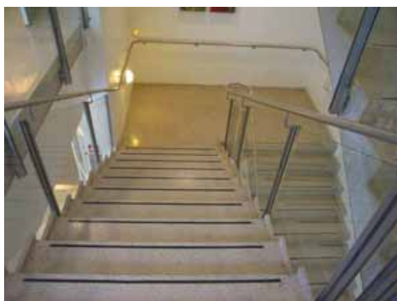
Figur v.64 Innfelt merking av forkant inntrinn
