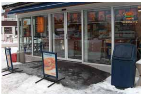
Figur v.4 Glassmarkering mangler både på bensinstasjonen og i et kjedeuavhengig gatekjøkken i handlegata.
