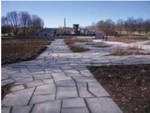
Figur v.81 Skiferheller gir ujevn overflate
