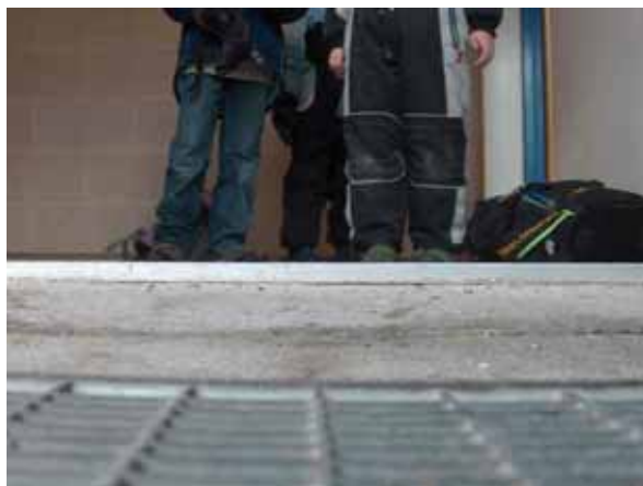
Figur v.32 For store terskelhøyder og nivåforskjeller på mange ytterdører.
