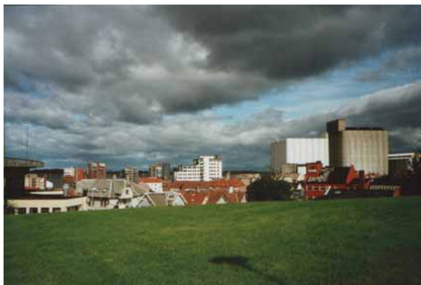
Figur 8.5 Bebyggelsen i Badedammenområdet sett fra bydel Storhaug. Bebyggelsen stenger for kontakt med sjøen
