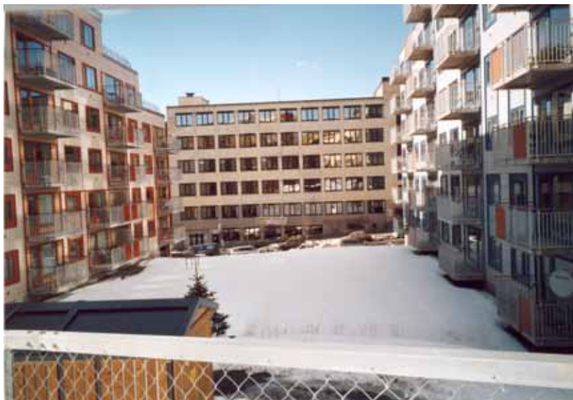
Figur 6.1 Foto av felles utearealer mellom lamellene sett mot Sinsenveien ved vårjevndøgn ca kl. 1500.. Uterommet oppleves som et lukket gårdsrom fordi bebyggelsen i Sinsenveien stenger for utsyn. Balkonger på begge sider forsterker problemet med innsyn og at man føler seg beglodd.
