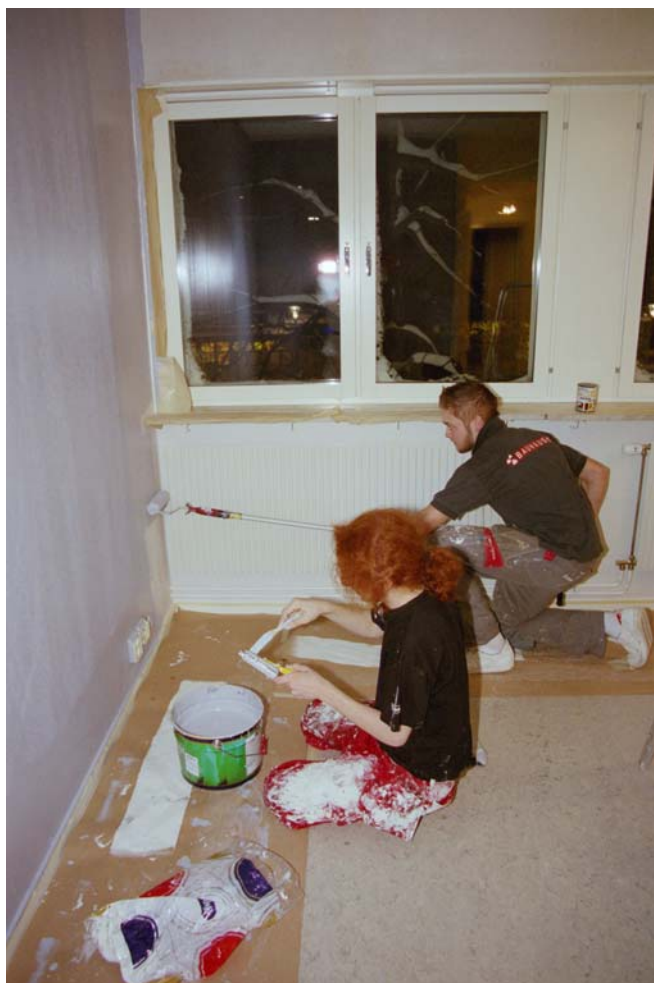
Figur 12.2 Arbeidsledig ungdom renoverer et tidligere kontorlokale og innreder sine egne leiligheter. Eksempel fra Skarpnäck i Sverige. Foto: Per Blanck
