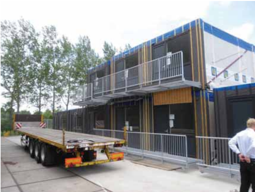
Figur 9.10 Ferdige moduler, klare til levering. Foto Moelven
