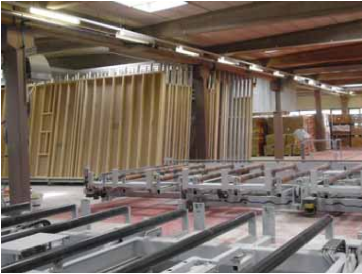
Figur 9.9 Veggbuffert før montering av isolasjon og røropplegg. Foto Moelven
