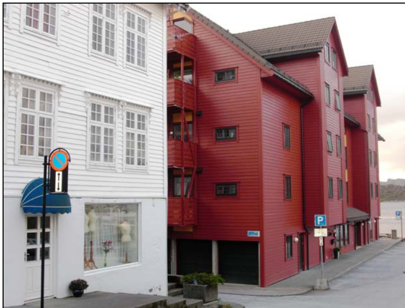
Gammel bebyggelse og nye boligbygg ved sjøen
