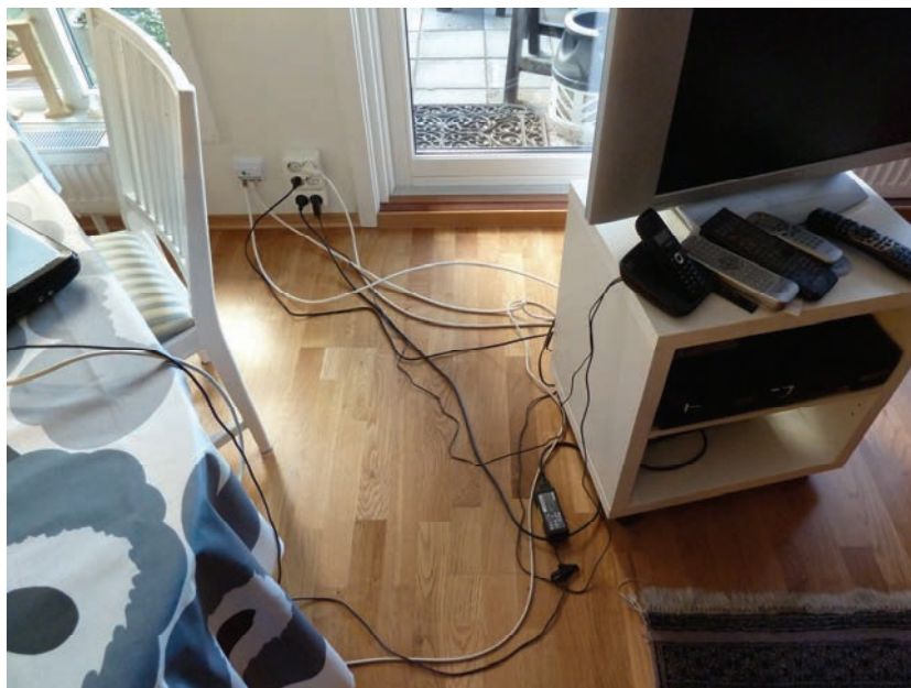
Figur 9.9 Kabler mellom oppholdsrom og dør til balkong som kan være farlige snubletråder (Solsiden D).
