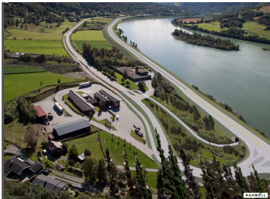
Figur 6.4 Den valgte løsning for ny E6 mellom Bredevangen og Solhjem i Sel
