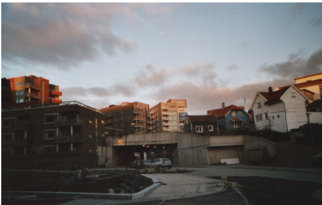
Figur 8.8 Den indre gangveien i Badedammenområdet ender i en parkeringskjeller. En forgjenger må finne gangveien til siden for "hullet" for å komme opp på parkeringslokket.
