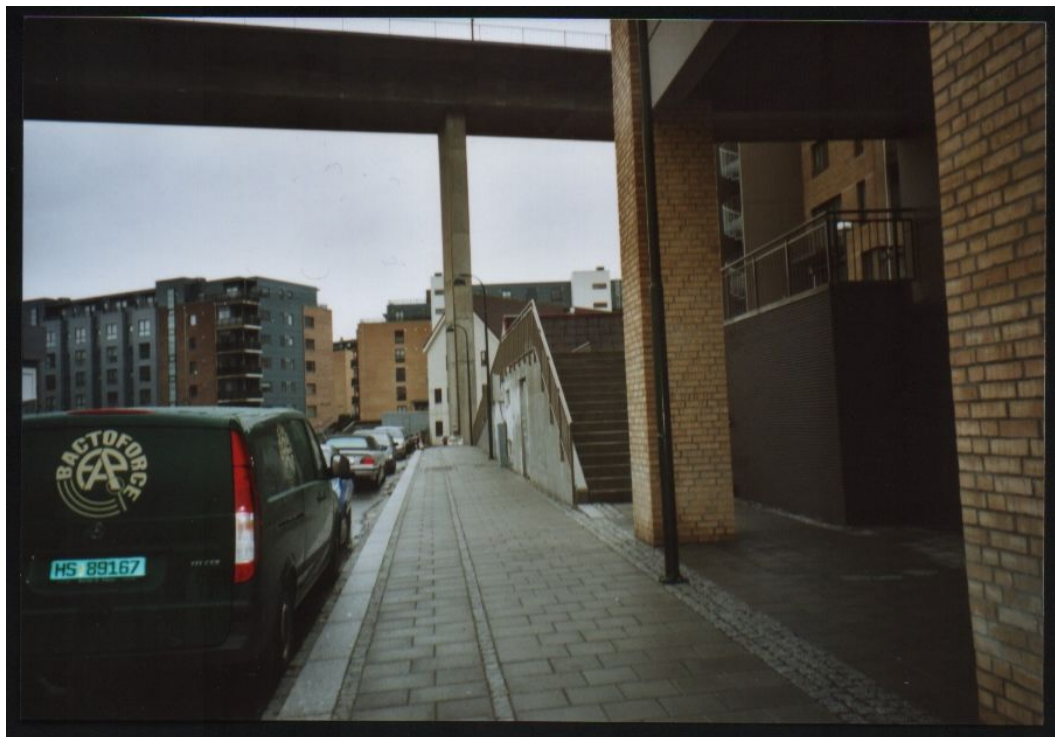
Figur 8.3 Gatebilde fra Verven. Trappen til høyre er nødvendig for å komme opp på "lokket" over parkeringskjelleren. Slike løsninger der parkeringskjeller danner veggen i det felles gaterom er i strid med retningslinjene for kommunedelplan for sentrum. Løsningen stenger også for kontakt med sjøen.
