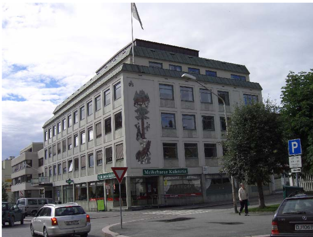
Administrasjonsbygning for skognæringene
