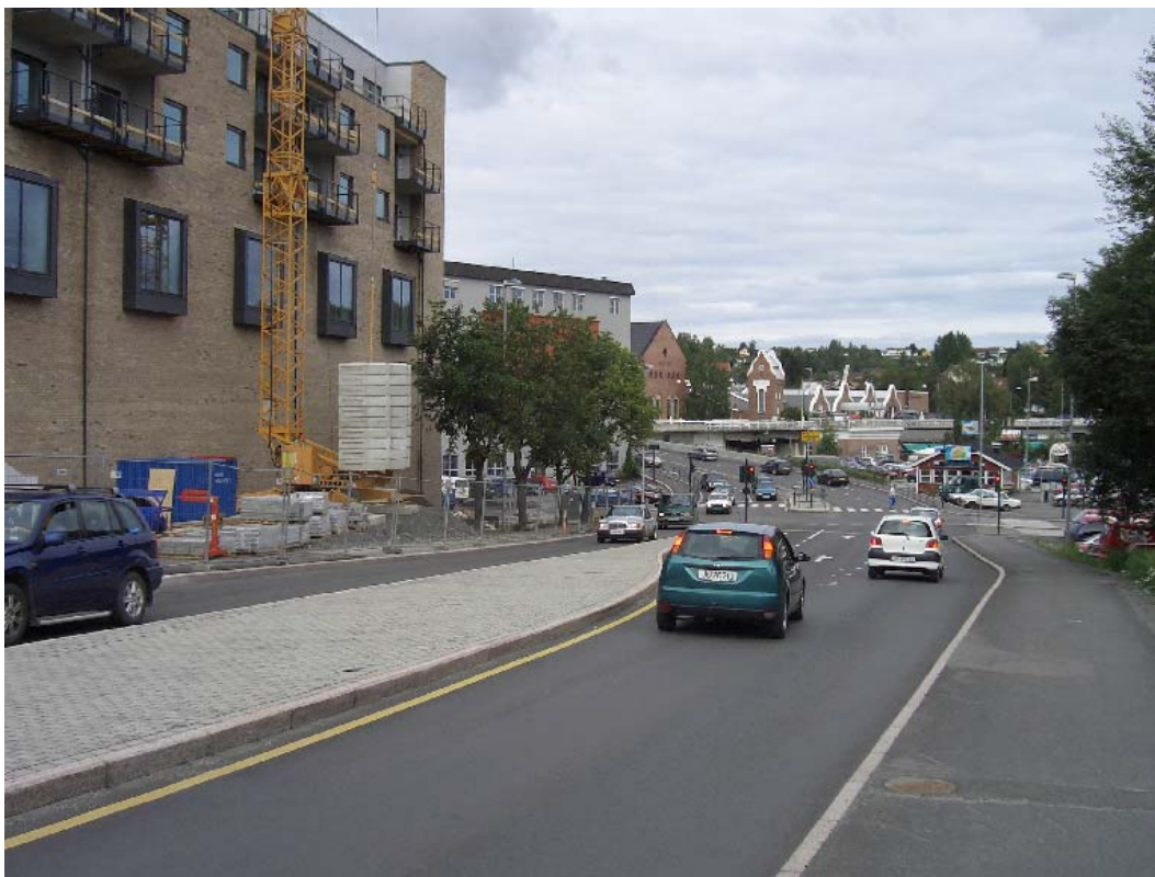
Kongens gate, en omkjøringsvei for tiltagende biltrafikk. Sentrumskvartalet til venstre.
