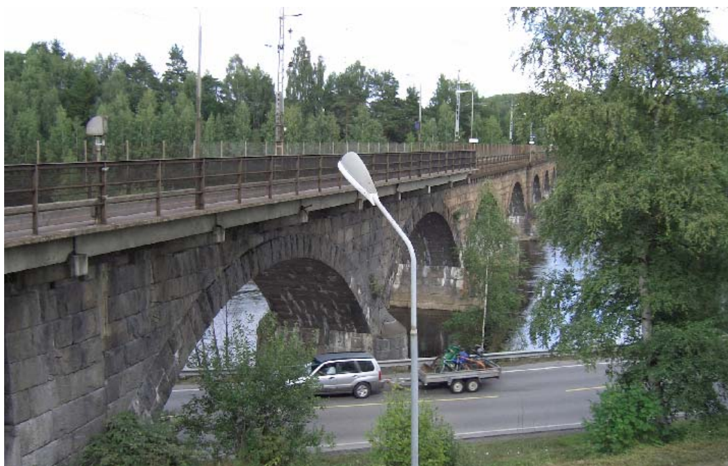
Jernbanebrua ved Hønefoss stasjon
