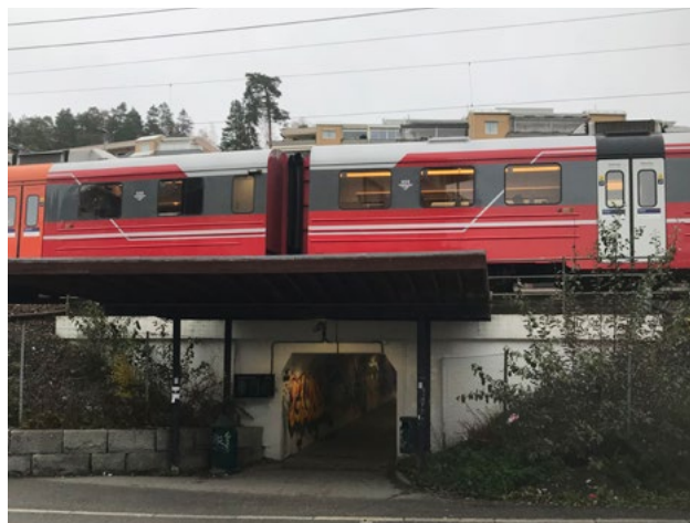
Dagens inngangsparti til Kolbotn stasjon er ikke innbydende. Undergangen fungerer også som fotgjengerforbindelse mellom nye og gamle sentrum.
