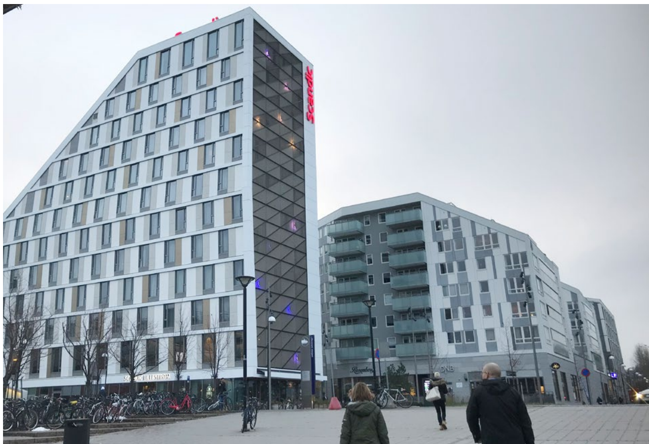
Lillestrøm Syd, med prosjektet Portalen, sett fra stasjonen.
