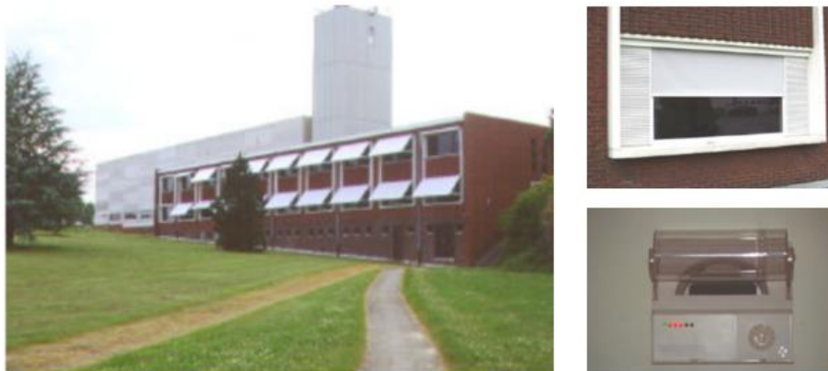
Figur 11: PROBE bygget, øverst til høyre: Rister for intensiv ventilasjon, nederst til høyre: Tilluft med tilstedeværelsesdetektor (Wouters et al., 1999)
