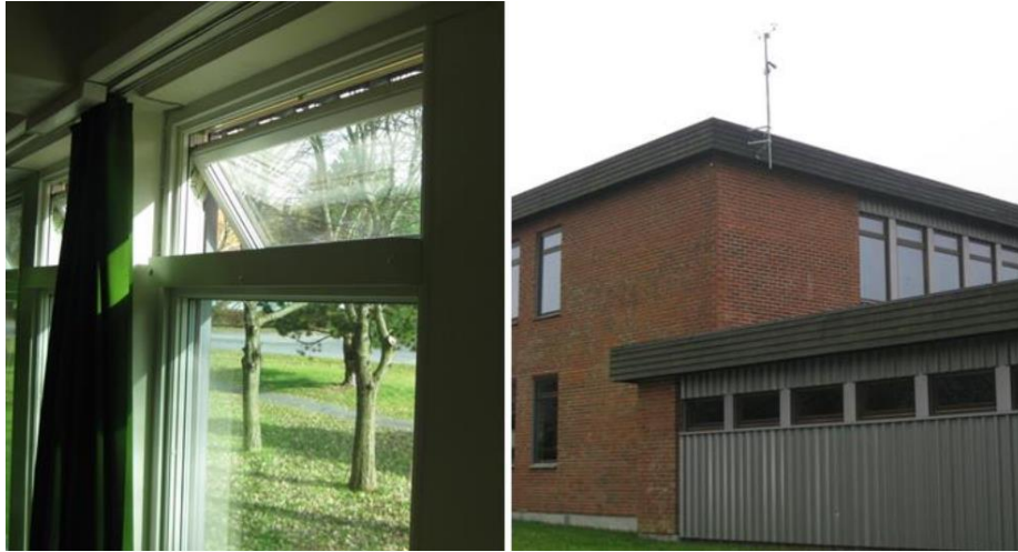
Figur 6: Automatisk styrt vindu som benyttes for vinduslufting og værstasjonen på taket (Algrøy, 2014, s. 38)
