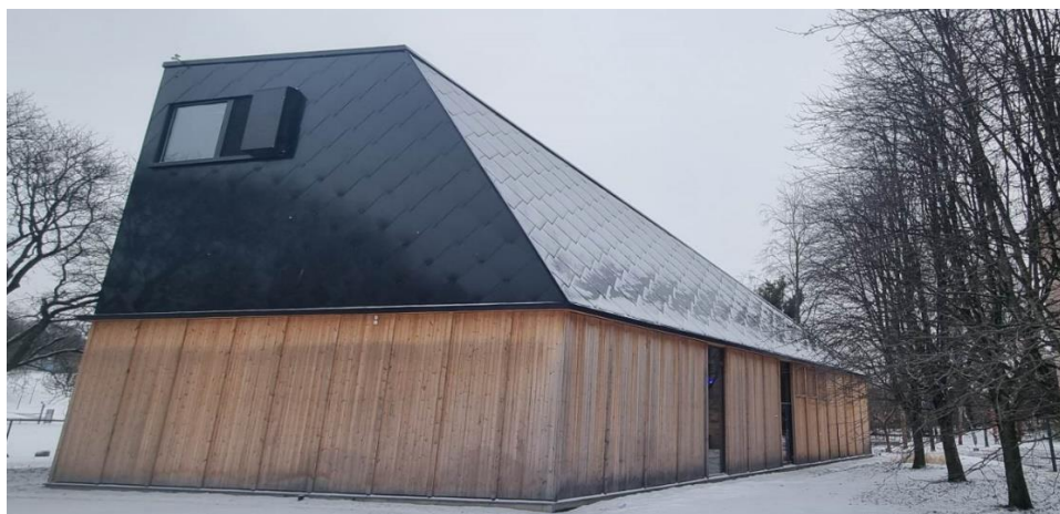
Figur 23: Bildet er tatt av bygget som viser luka i Nord-fasaden
