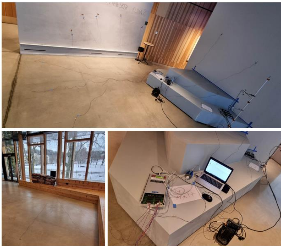
Figur 31: Øverste bildet er tilkoblede Thermocuple elementer på overflater og logging på PC på Utstillingsarealet samt bilde nederst til venstre. Bilde nederst til høyere er samme logging i Amfiet
