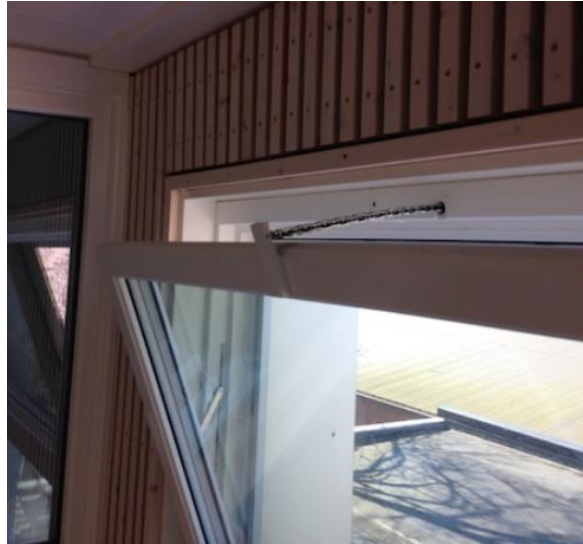
Figur 5: Vindu med integrert sytringsmotor, med maksimal åpningsgrad (Lie, 2015, s. 37)
