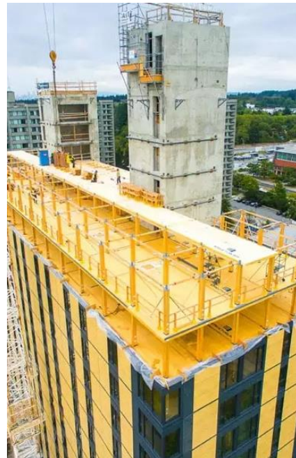
Figur 2.11: Bærekonstruksjonen i Brock Commons Tallwood House i Canada (Demonstrating the viability of mass wood structures, 2022)
