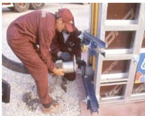
Figur 2.7 - Støping med formventil (Rescon Mapei, 2002)
