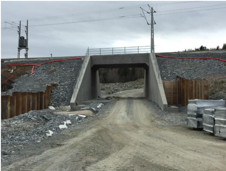
Figur 35: Vegkulvert etablert under den eksisterende jernbane i Kongsberg. Foto: Sebastian Horn Baksaas
