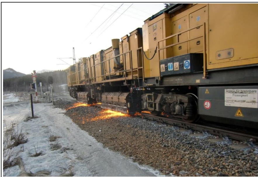
Figur 29: For redusert støy, god kvalitet på sporet og lang levetid på skinnene utføres det jevnlig skinnesliping. Foto: Stig Arne Brenden (Ramstad, 2012).
