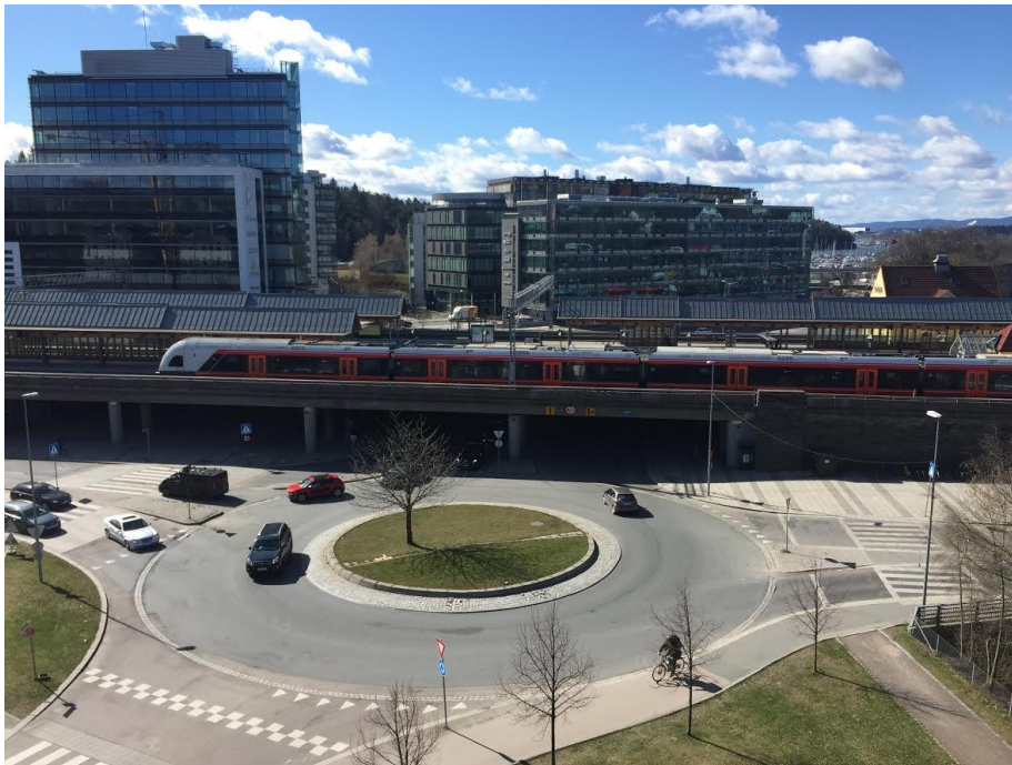
Figur 33: Skøyen togstasjon. Her ser vi hvordan vegnettet går under en kort brubane. Foto: Sebastian Horn Baksaas.
