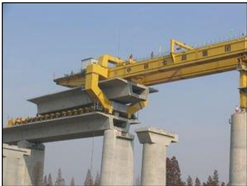
Figur 26: Montering av prefabrikkerte element Kilde: (Teacherweb)
