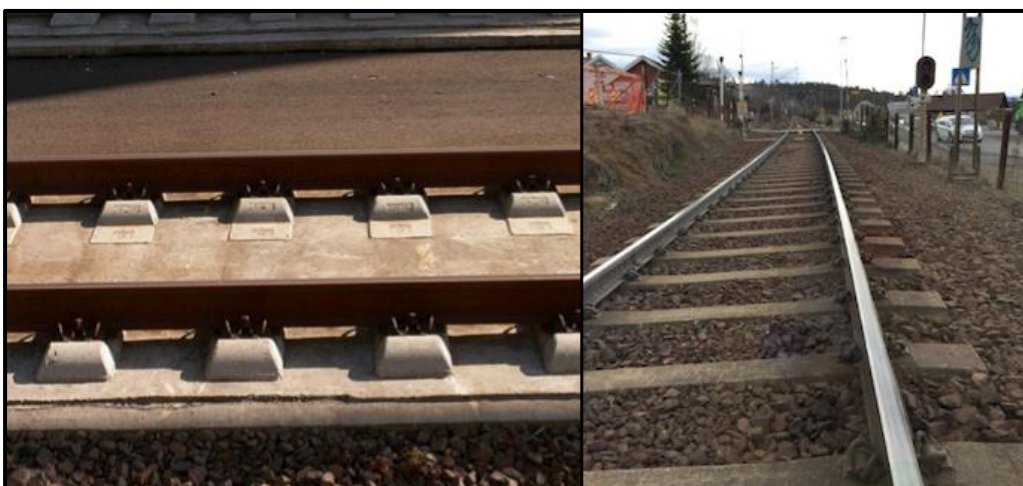
Figur 12: Fast ballast benyttet i Tyskland (Railway-Technology, 2017) og spor med konvensjonell ballast, henholdsvis til venstre og høyre.
