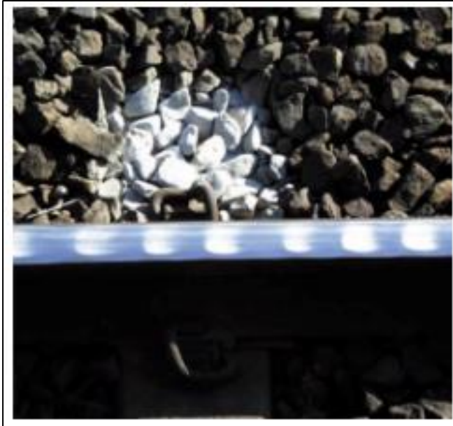
Figur 28: Ujevnheter på skinneoverflaten hvor et vedlikeholds inngrep er nødvendig (Jernbaneverket, 2013).
