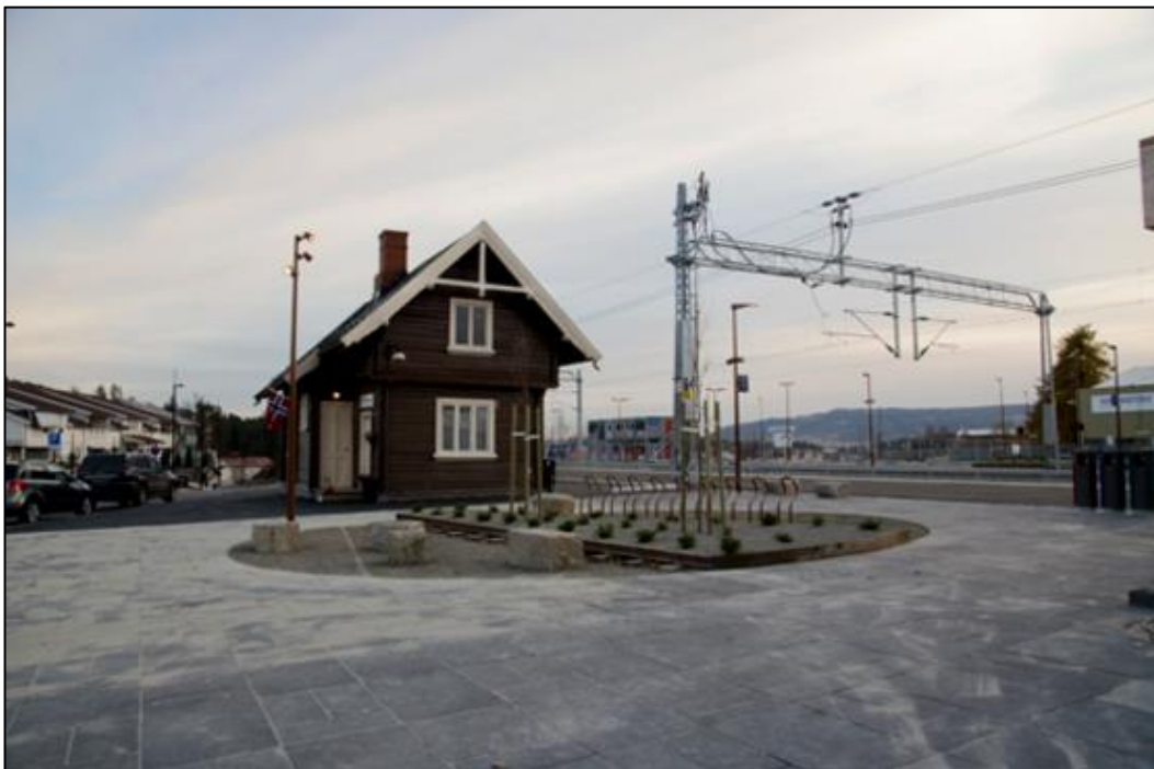
Figur 5: Moelv stasjon i 2012 etter det estetiske og funksjonelle løftet, prosjektert av Rambøll for Jernbaneverket og Ringsaker kommune. Fotograf: Njål Svingheim Kilde: Bane NOR (Statistisk sentralbyrå, 2016)
