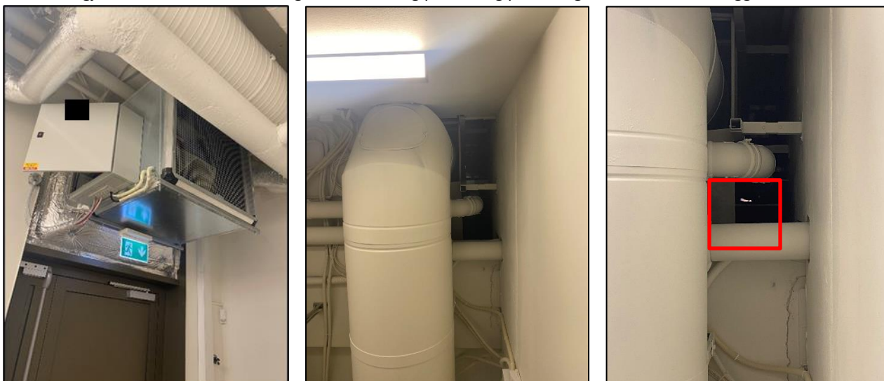
Figur 65: Trykkavlastningssjakten sett fra første etasje, foran viftene. Dagslys fra taket merket i rødt. Bildet tatt av Jonathan Lundblad 05/06/22
