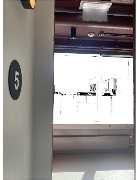
Trapp A2 hadde vinduer i fasaden fom. 4 tom. 17. etasje. Bildet manipulert for å anonymisere lokasjonen
