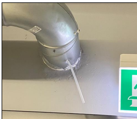
Figur 21: I kjelleretasjen på D1 måtte slangen føres gjennom en ventilasjonskanal på begge sider av veggen
