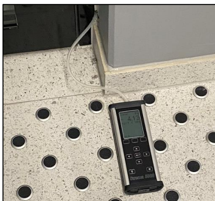
Figur 20: På øvrige etasjer i D1 og D3 var det ingen mulige gjennomføringer for slangen. Det ble derfor nødvendig å bore gjennom utforingen på døren.
