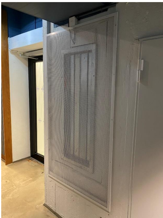
Felles trykkavlastning i kjeller, et. 0 og -1.
