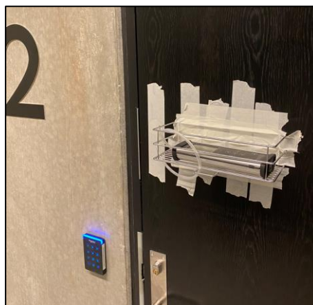
Figur 22: I A kunne låsesylindere demonteres. Kurvene måtte teipes fast, sugekoppene lot seg ikke feste på dørenes rye overflate.
