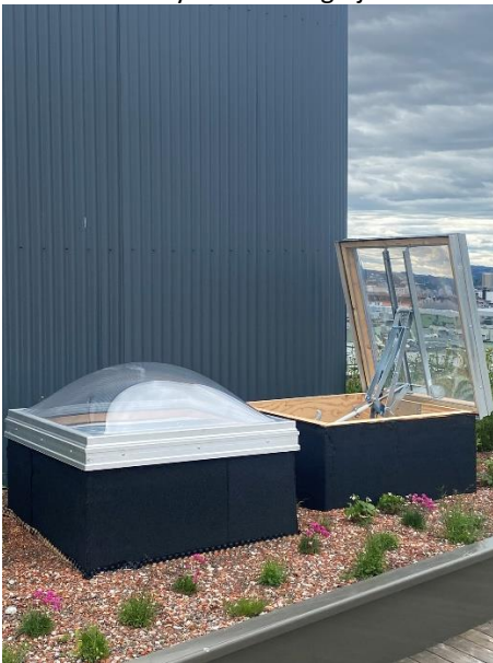
Luken i toppen av trapperommet foran luken til trykkavlastningssjakt
