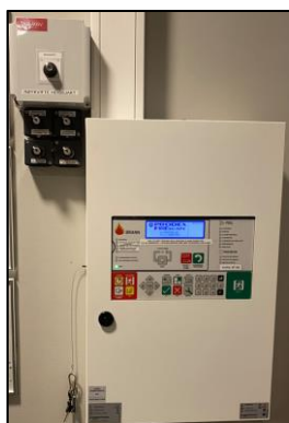
Figur 97: Branntablå i bygg C, type «Prodex FIREscape-multifunksjonssentral» fra Hedengren.
