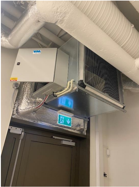
Luken i toppen av trapperommet foran luken til trykkavlastningssjakt
