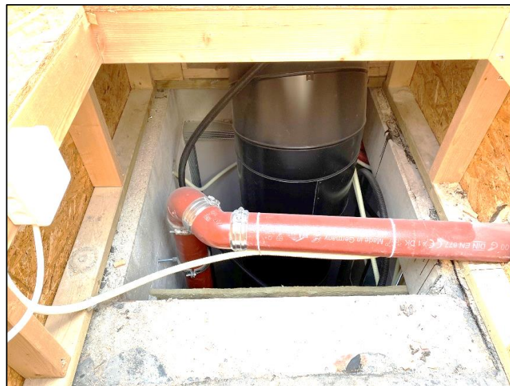
Figur 64: Innsiden av trykkavlastningssjakten til B2. (Merk: avbildet fra luken i Figur 56) Bildet tatt av Jonathan Lundblad 05/06/22
