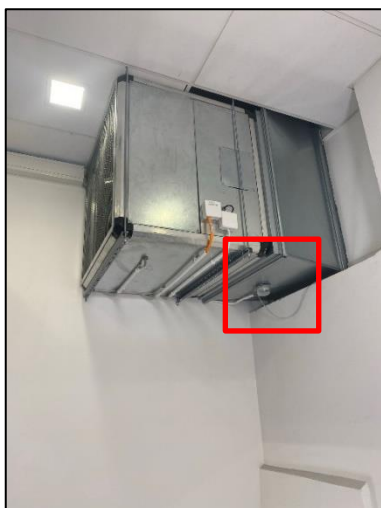
Figur 31: Trykksettingsvifte i toppen av trapperommene, trykkdifferansegiver markert rødt. Bildet tatt av Jonathan Lundblad 29/11/21
