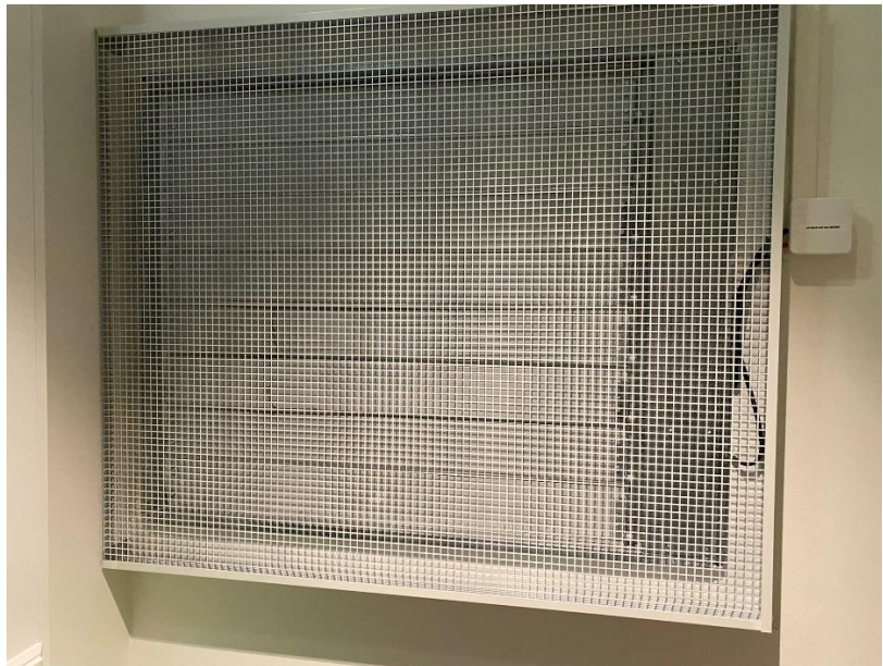
Trykkavlastningsspjeldene anvendt i sluserommene
