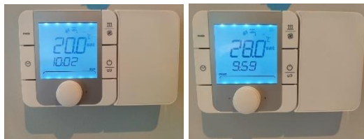
Figur 32: Carel – Romtermostat satt til 20 °C romtemperatur & 28 °C turtemperatur
