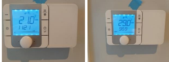
Figur 31: Carel – Romtermostat satt til 21 °C romtemperatur & 29 °C turtemperatur
