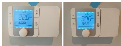
Figur 30: Carel – Romtermostat satt til 22 °C romtemperatur & 30 °C turtemperatur
