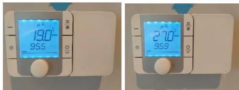
Figur 33: Carel – Romtermostat satt til 19 °C romtemperatur & 27 °C turtemperatur
