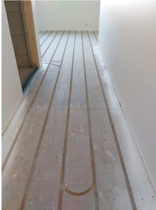
Figur 13: Sponplate med spor til PEX – rørsløyfer
