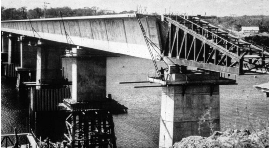
Figur 13: Lanseringsnese av fagverksbjelker ved Caroni bridge, i et tidlig stadium i historien (Bridge Tech, u.å.)
