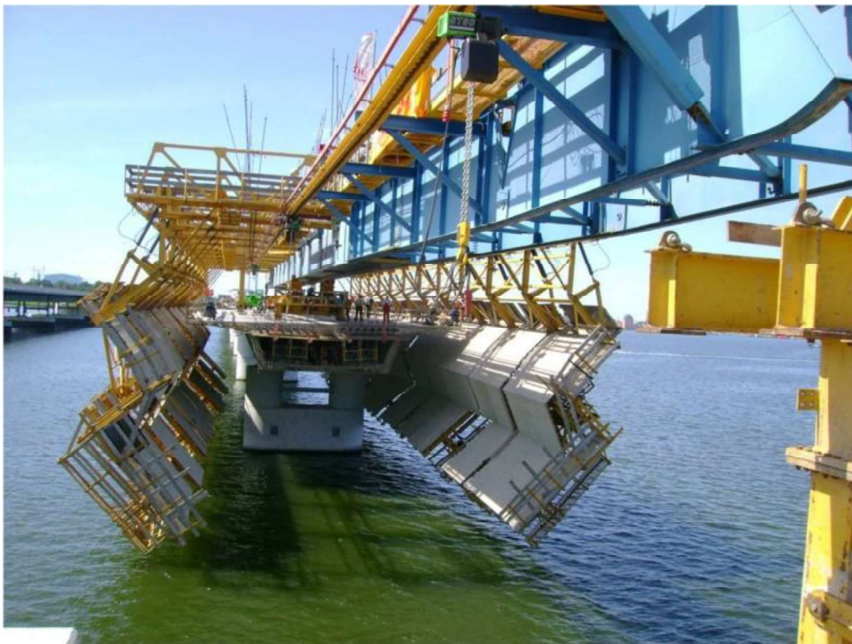
Figur 11: Movable Scaffolding System (MSS) er en produksjonsmetode som kan brukes hvor det er vanskelig tilgjengelig, for eksempel ved brubygging over vann (Strukturas, u.å.)
