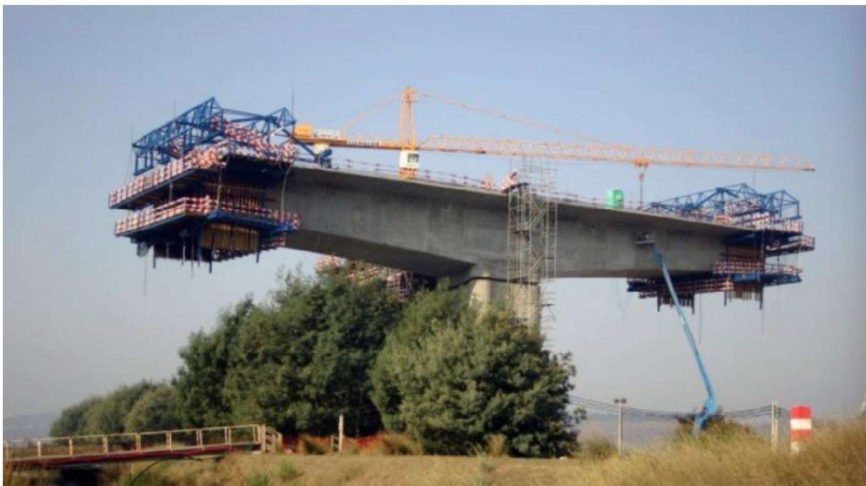
Figur 10: Fri utkrager med overhengende støpevogn (Strukturas, 2021)
