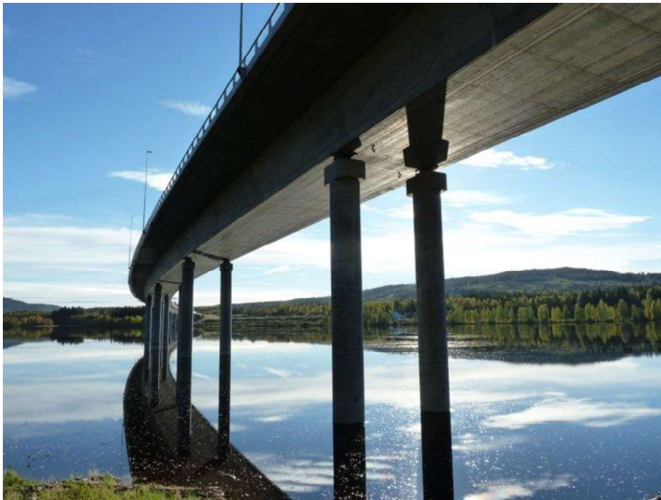
Figur 1: Gulli Bru ble bygget med lanseringsmetoden i 2014 (Byggeindustrien, 2015).
