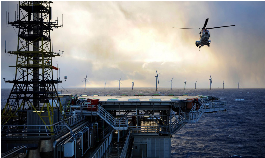
Møte mellom gammel og ny teknologi. I horisonten sees Tampen Hywind flytende havvindpark. Bildet er tatt fra Snorre-plattformen. Foto: Equinor/Laila Sømme.
