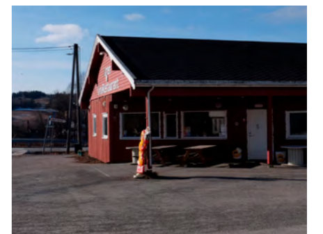
[bilde 4.4] Fasaden av Jaren Kinarestaurant
