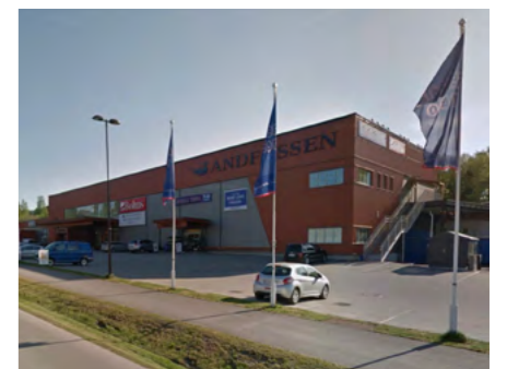
[bilde 4.3] Fasaden av Andfossen senter
