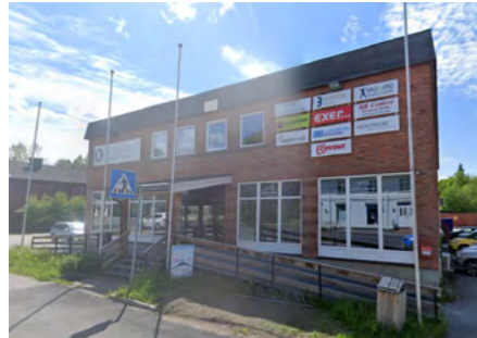
[Bilde 6.1, over] Bilde tatt fra fremsiden ved Storlinna 73, Brandbu
