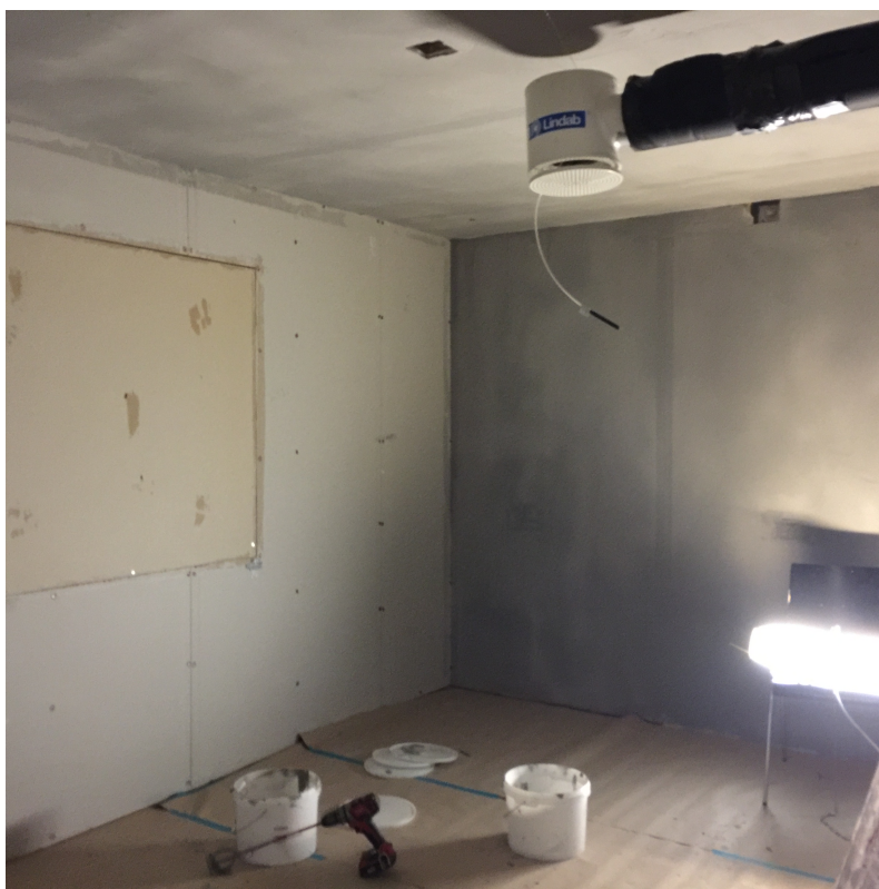
Figur 3.23: Påføring av PCM-sparkel på vegg- og himlingoverflatene
