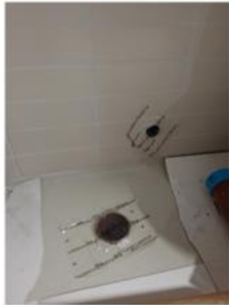
Figur 21. Tetting av rørføringer til venstre og tetting av dusjsluk i garderobe til høyre.
