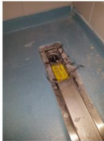
Figur 21. Tetting av rørføringer til venstre og tetting av dusjsluk i garderobe til høyre.
