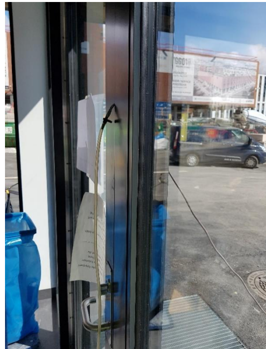
Figur 26. Montering av plastrør i dør i første etasje.
