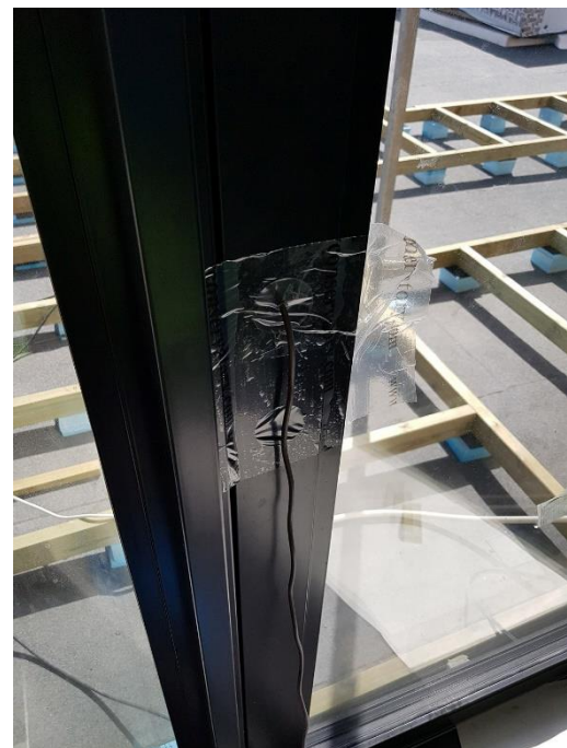
Figur 28. Montering av plastslange gjennom dør i 4. etasje.
