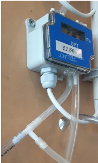
Figur 6: Tilkobling av T-stykke [Foto: E. Sørbotten].
