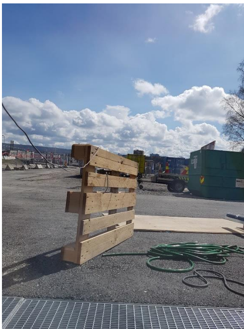
Figur 27. Plastslange på pall ved måling av referansetrykk i 1. etasje.
