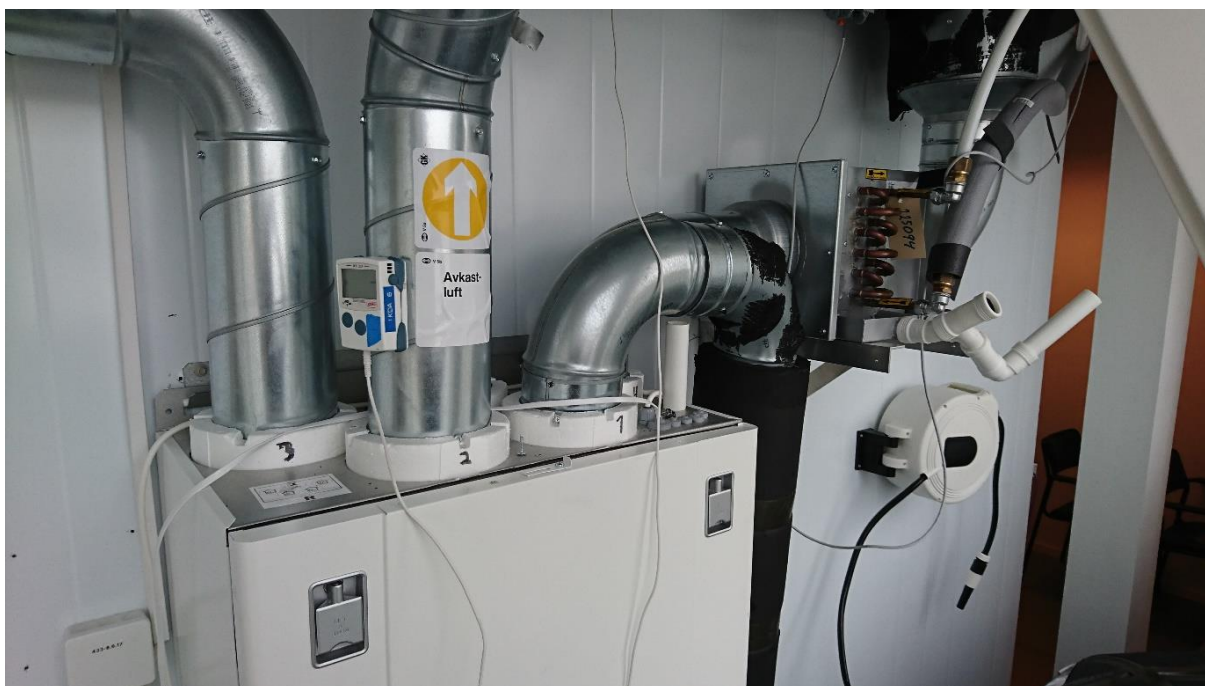
Figur 10. Ventilasjonsaggregat med modifisert kjøler.
