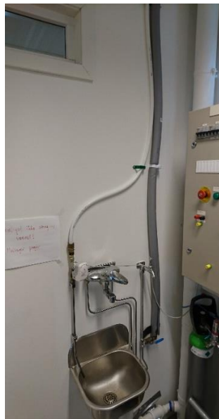
Figur 13. Sammenslåing av kaldtvann fra bygg til kjøler.
