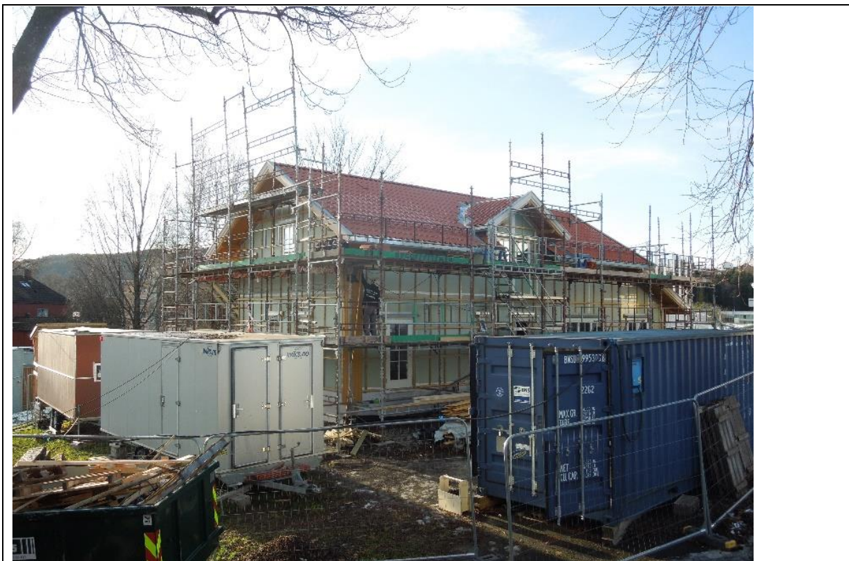
Figur 2. Drengestua, Nordre Bondi Gård. Utførende: TBA Nesbru vgs. Ansvarlig utførende: Haandverkerne as. Tiltakshaver: Asker Kommune.
