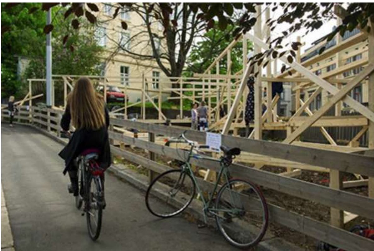
Transformer Ullevålsveien 75 www.urbantransformer.no Foto: Vigdis Storsveen Gjengitt med tillatelse
